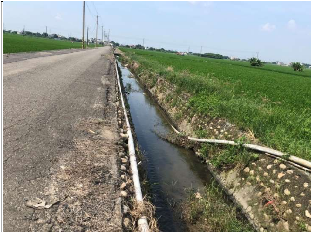
線名：三間厝小排二現況相片 現況：0+450 砌石工 拍攝日期：109.08.31；座標 X=187564，Y=2602861
