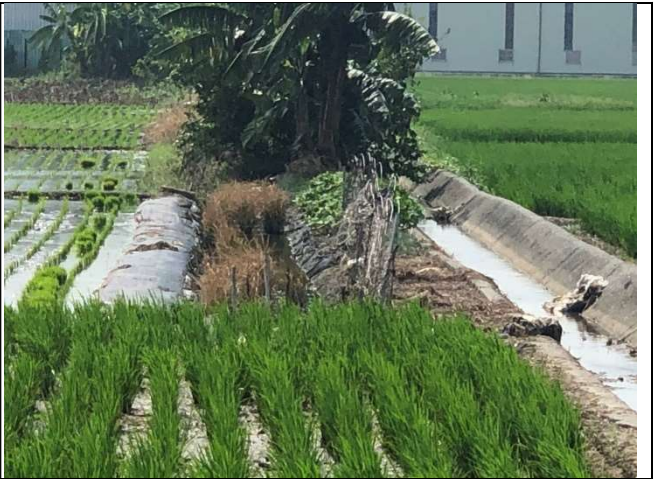
線名：三間厝補排二之二現況相片 現況：0+050 土渠 拍攝日期：109.08.31；座標 X=187531，Y=2602924
