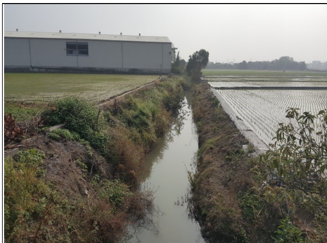
線名：頂半天中排 現況相片 現況：1+889 土渠 拍攝日期：109.08.28；座標 X=182510，Y=2590096
