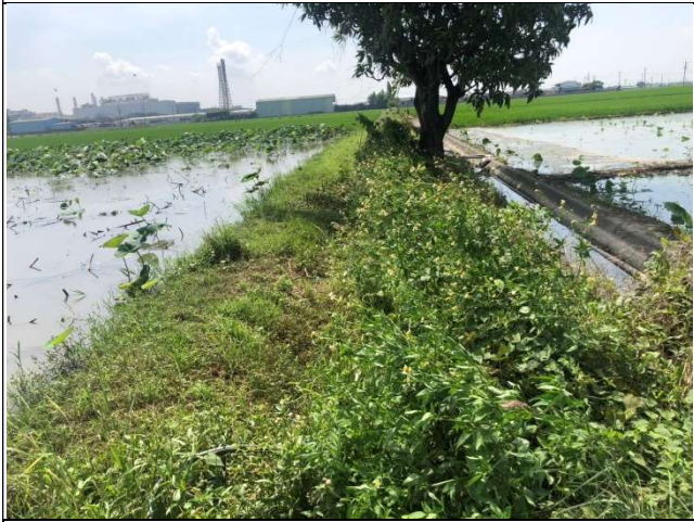
線名：三間厝補排四之一現況相片 現況：0+050 土渠 拍攝日期：109.08.31；座標 X=187544，Y=2602666
