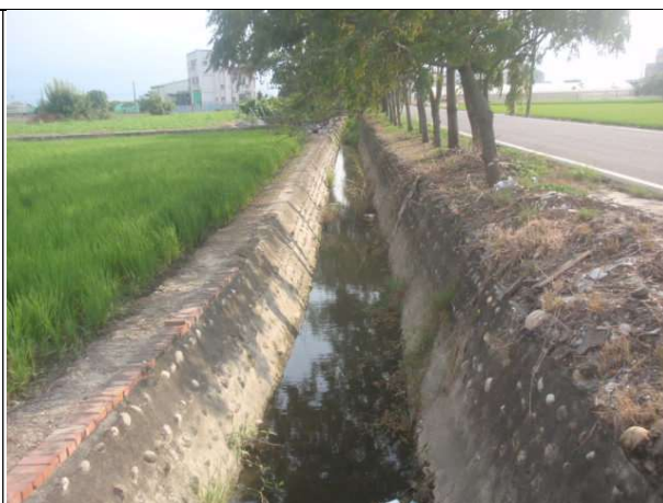
線名：潭底子小排一現況相片
