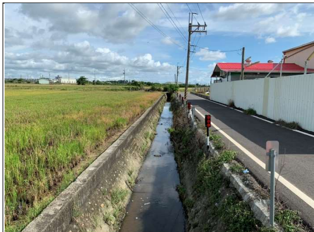
線名：大埤大排 現況相片
