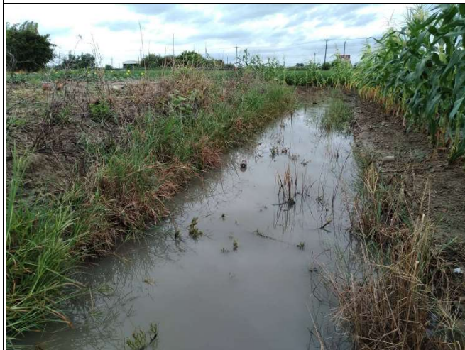
線名：北龜佛山小排二之一 現況相片
