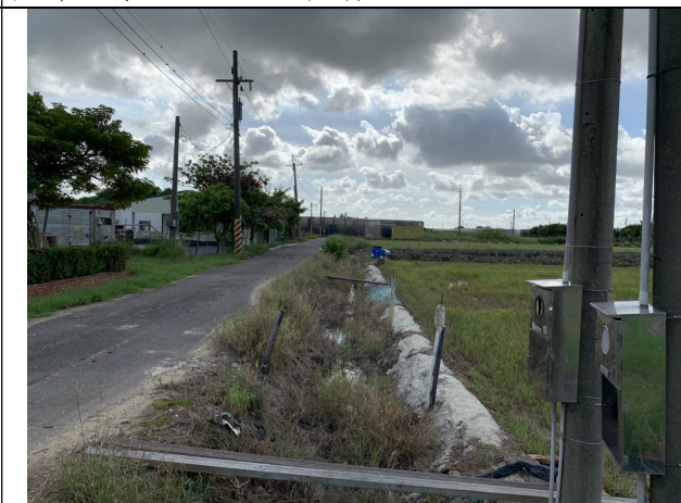
線名：大埤小排二之七 現況相片
