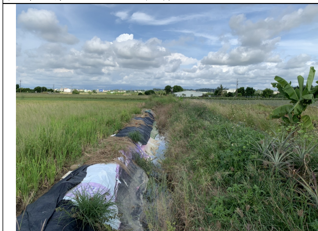
線名：大埤小排二之六 現況相片
