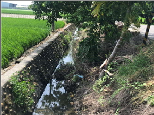
線名：南社溝中排一現況相片
