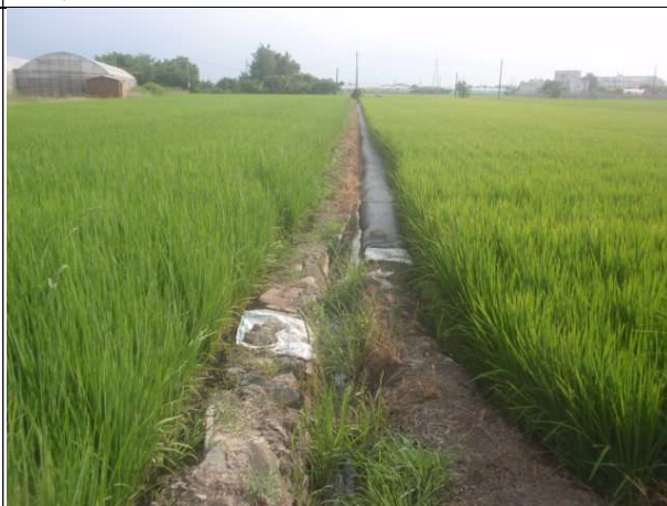
線名：潭底子小排一之八現況相片
