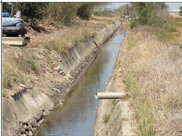
線名：後鎮中排二現況
