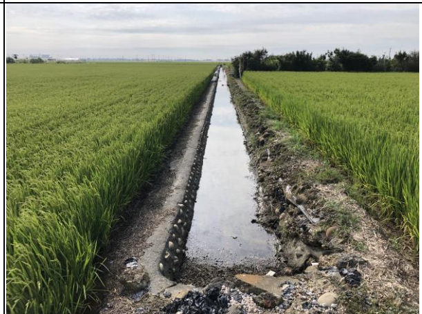
線名：北龜佛山小排一之七 現況 現況：0+000 砌石工渠道 拍攝日期：111.05.04；座標 X=176451，Y=2589363
