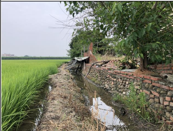
線名：竹子腳小排二之七 現況 現況：0+000 砌石工渠道 拍攝日期：110.04.20；座標 X= 176738，Y= 2587994
