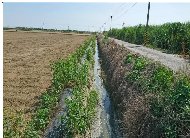
線名：北上溪洲小排三現況
