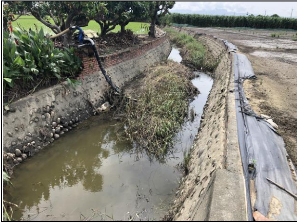
線名：龜佛山中排一 現況 現況：0+807 砌石工渠道 拍攝日期：110.08.12；座標 X= 175718，Y= 2588124
