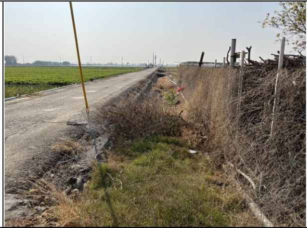
線名：龜佛小排一之五 現況 現況：0+000 砌石工渠道 拍攝日期：112.03.09；座標 X= 176029，Y= 2588677
