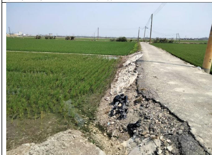
線名：新庄小排三之十七 現況 現況：0+000 土渠 拍攝日期：112.03.15；座標 X= 175697，Y=2591060
