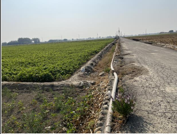
線名：龜佛小排一之六 現況 現況：0+000 砌石工渠道 拍攝日期：112.03.09；座標 X= 176030，Y= 2588673
