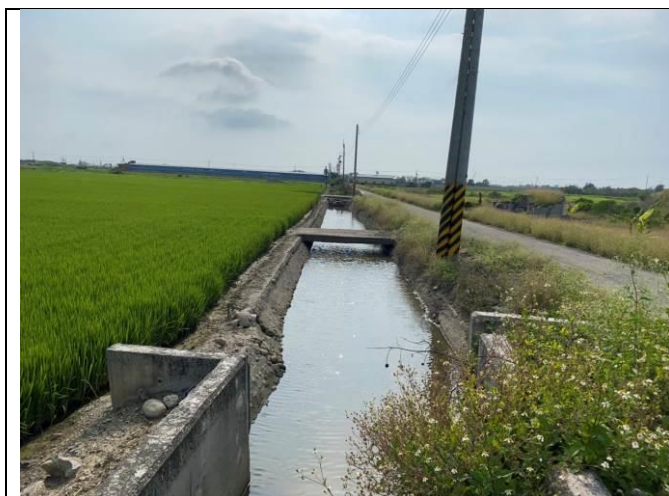
線名：西炭後小排一之二 現況 現況：0+000 砌石工渠道 拍攝日期：111.04.28；座標 X= 169801，Y= 2594509
