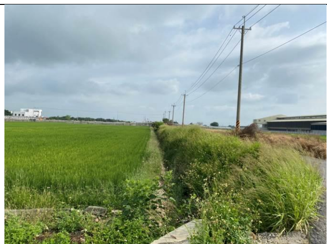
線名：炭前小排三之七 現況 現況：0+665 砌石工渠道 拍攝日期：111.04.28；座標 X= 171489，Y= 2592693
