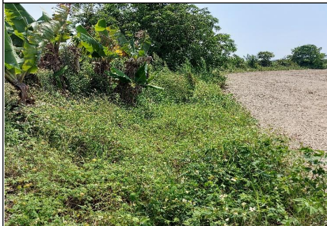
線名：尾寮小排 1-14 現況
