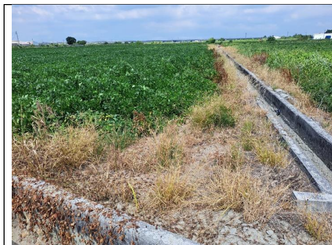
線名：安溪寮小排一之七 現況
