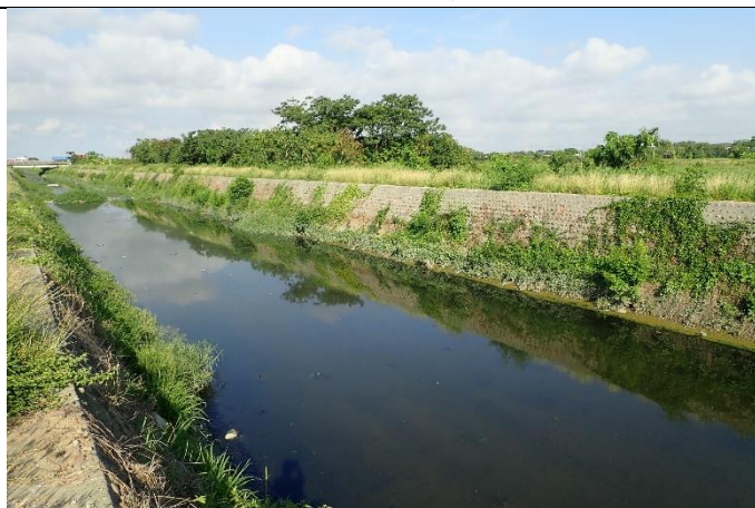
工區東側往西側拍
