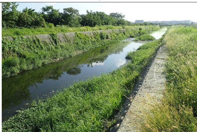
工區西側往東拍
