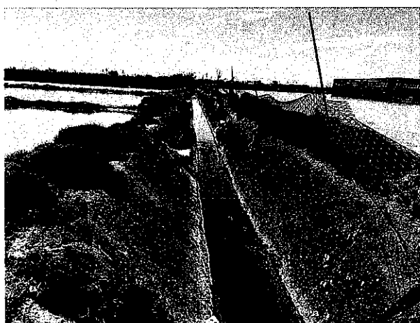
時間：113 年 8 月 22 日 說明：渠道內現況
