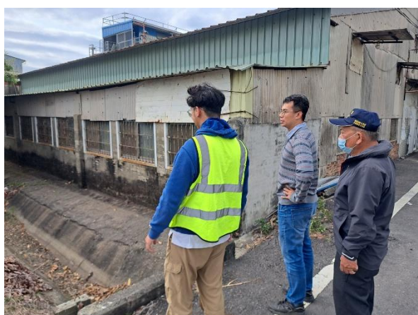
說明：頂港小給一之二 委員現勘實景
