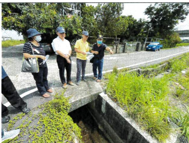
說明：路東小排二現勘
