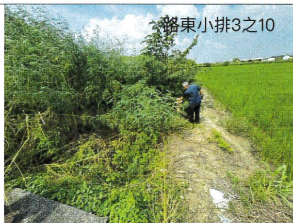
說明：路東小排三之十現階段為土溝
