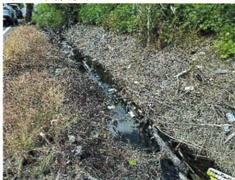
說明：小排現況
