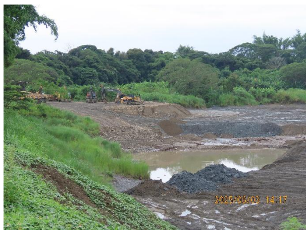
日期：114 年 6 月 3 日 位置：工區西側既有工程（基地範圍外）
