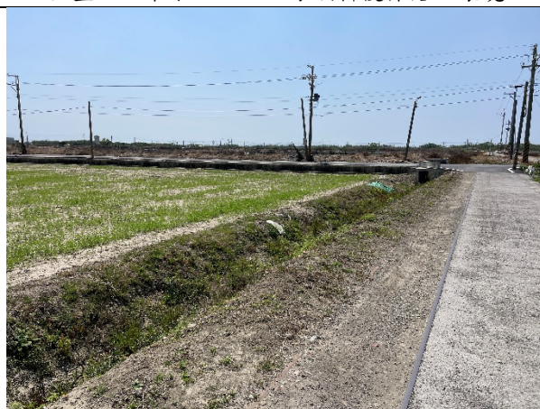
日期：114 年 3 月 25 日 位置：佳里小排二之三溝渠隙地旁舊有台糖鐵軌
