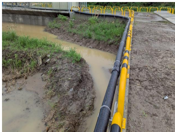
時間：114 年 7 月 30 日 說明：頂埤抽水站導水路
