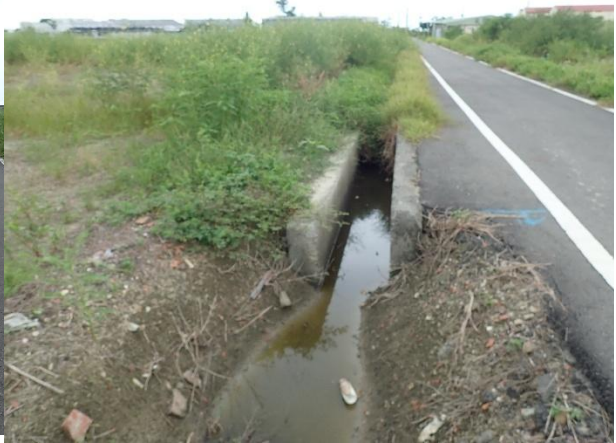
施工終點(線接新式 U 型溝)
