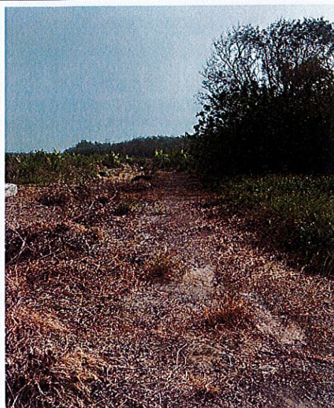
說明：渠道現況
