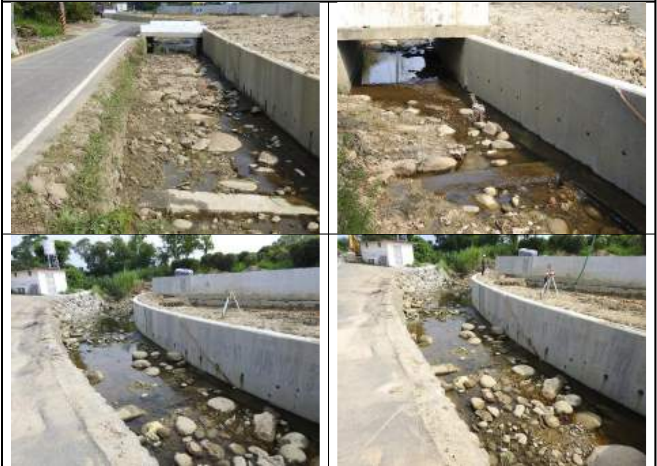
圖 4-3 固床工設計高度低於 50 公分以下
