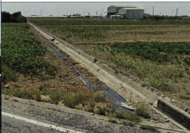
說明：北寮子小給二之八 現勘
