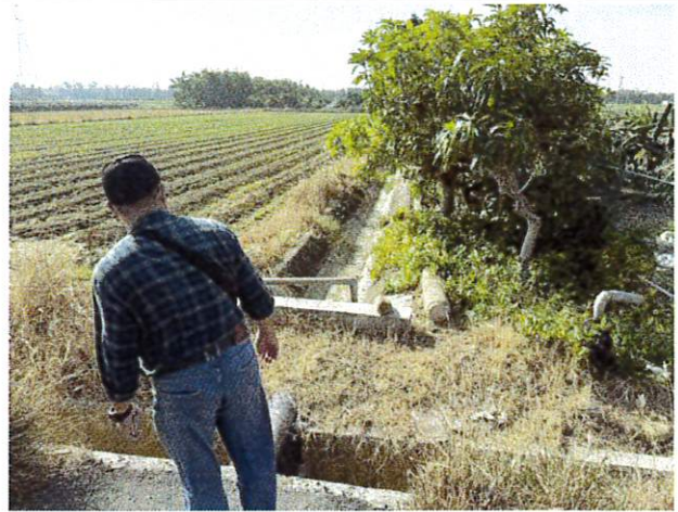
照片說明：專家、民眾參與現勘 (北急水溪小給一 114/12/10 攝)
