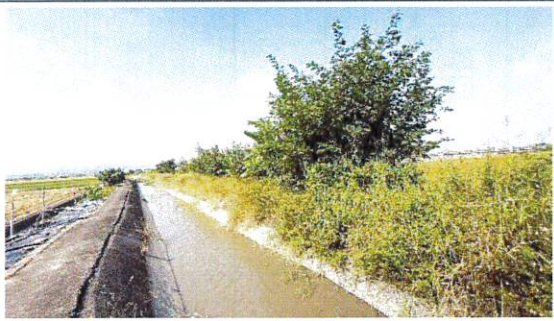
施工情形(此處尚未施作) 114.11.19
