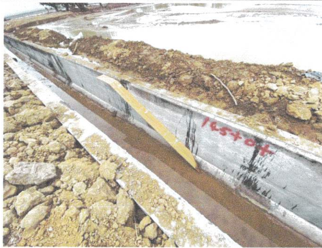
動物逃脫設施(0+145)設置情形 115.02.05
