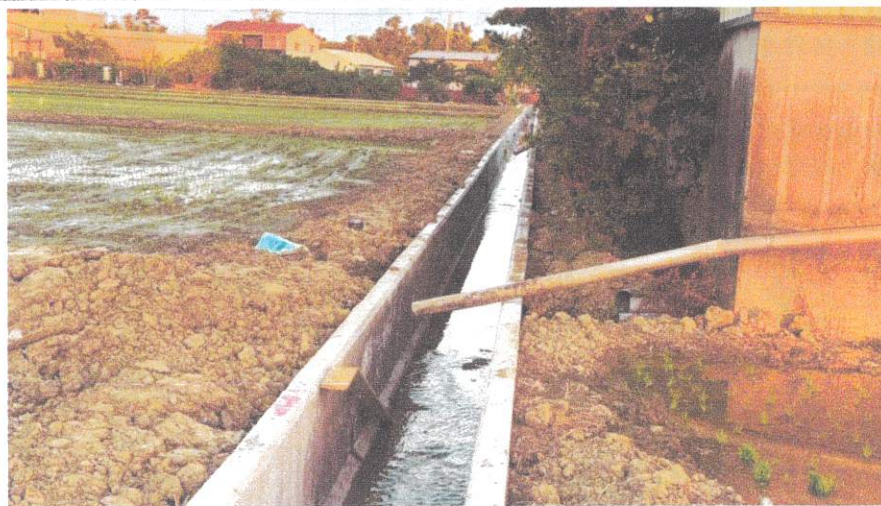
動物逃脫設施設置情形 115.02.05
