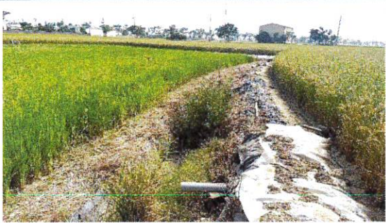
施工情形(此處尚未施作) 114.11.19
