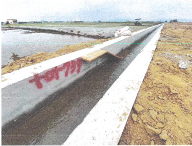
動物逃脫設施(0+739)設置情形 115.02.05
