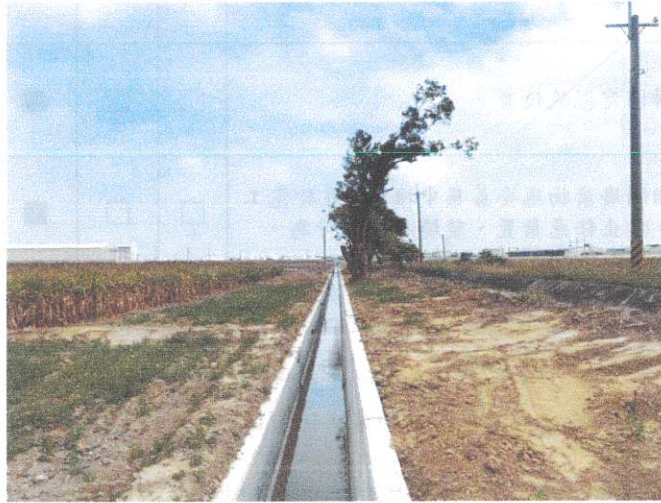
施工終點完工後復原環境 115.02.05
