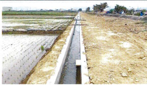
施工與便道復原情形 114.02.06
