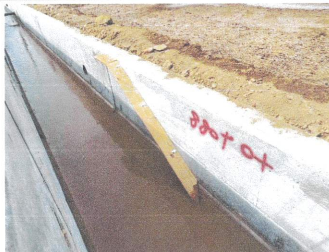
動物逃脫設施(0+880)設置情形 115.02.05
