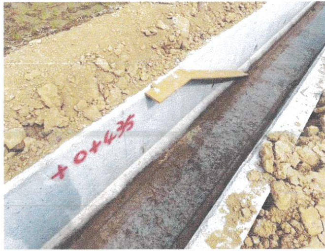
動物逃脫設施(0+435)設置情形 115.02.05
