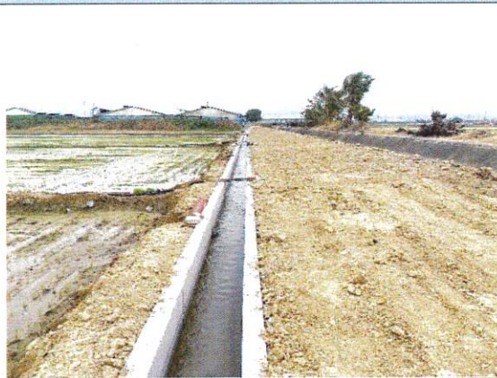
施工與便道復原情形 114.02.04
