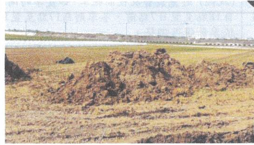
限制施工土方暫置範圍 114.11.17
