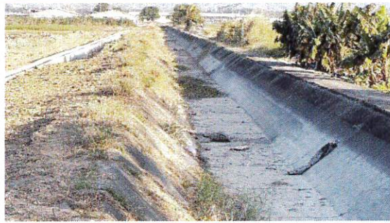
施工周邊圳路環境 114.12.26
