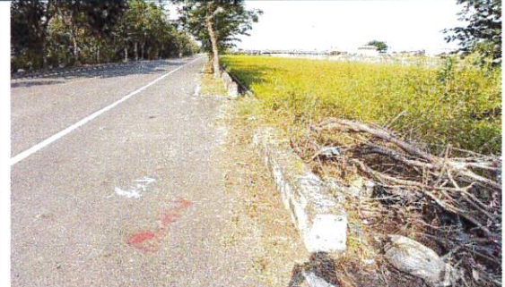
施工情形(此處尚未施作) 114.11.19
