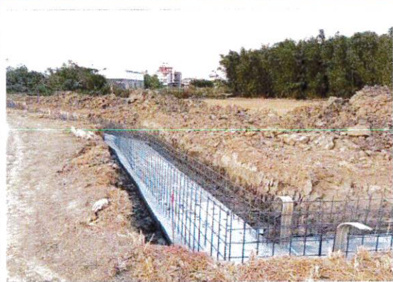
施工周邊竹林環境 114.12.30
