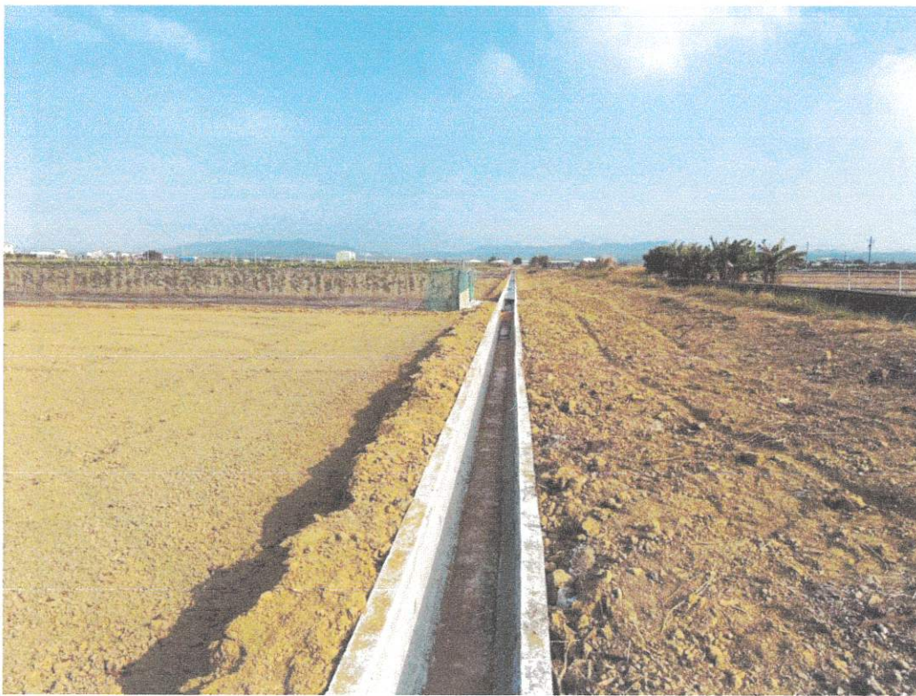
施工便道已復原 115.01.19
