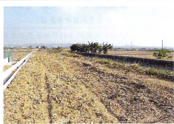
施工便道復原 114.01.21
