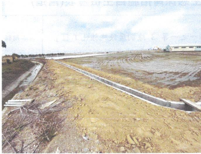
施工起點完工後復原環境 115.02.05
