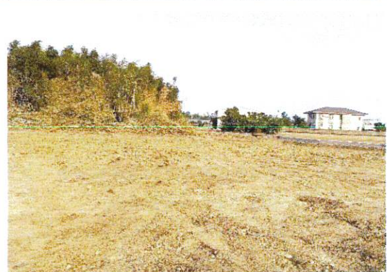
施工周邊竹林環境 114.01.21
