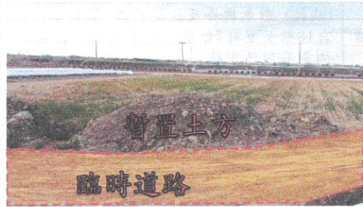
限制施工土方暫置範圍 114.12.29
