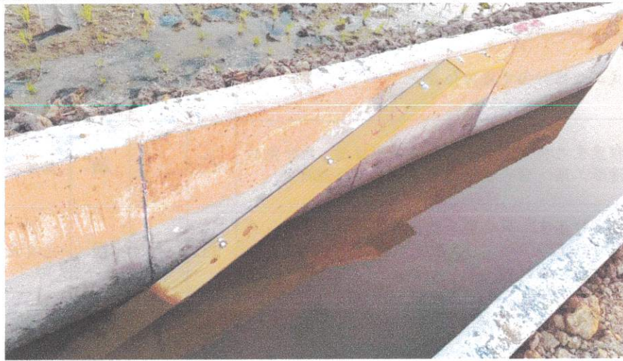
動物逃脫設施設置情形 115.02.05
