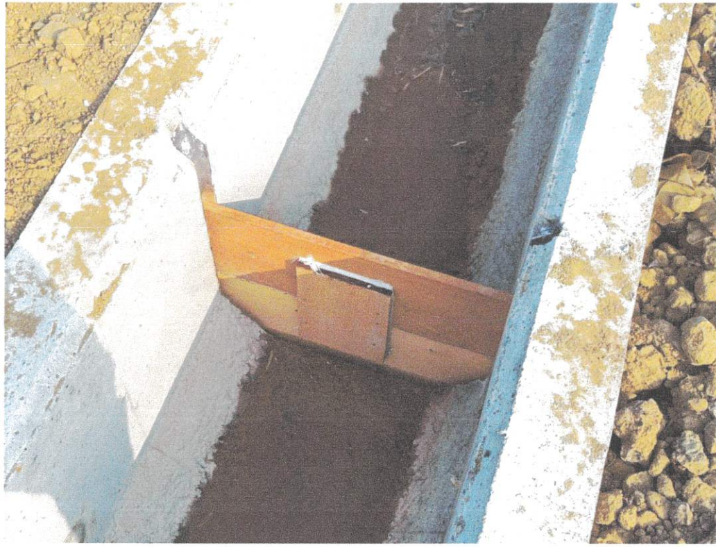
擋水板已設置 115.01.19
