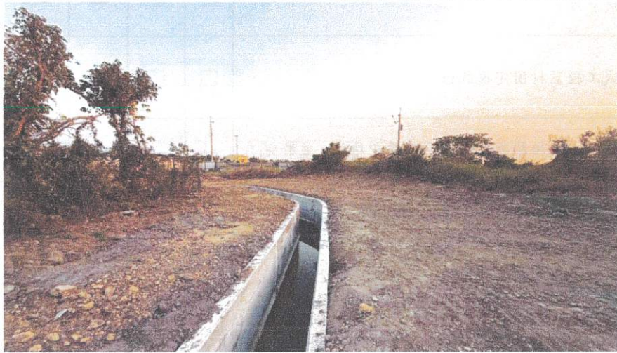
完工後復原環境現況 115.02.05
