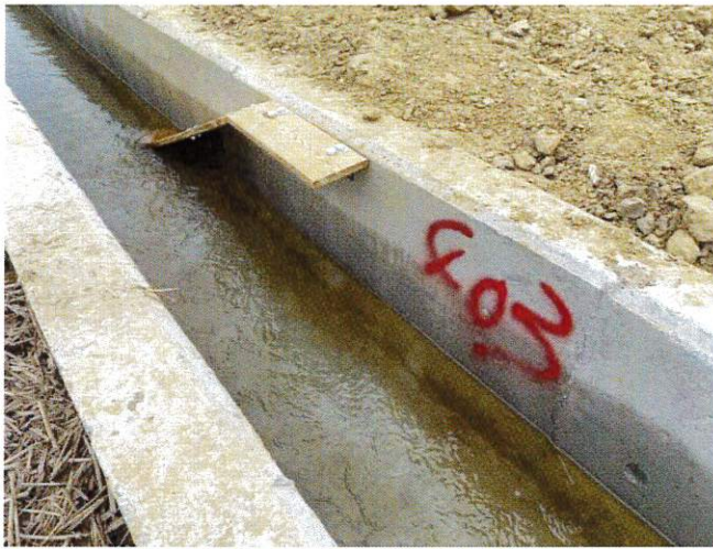
動物逃脫設施(0+403)設置情形 115.02.05
