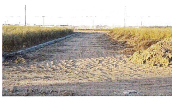
施工便道利用情形 114.12.26
