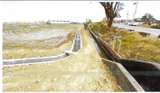
施工復原情形 114.02.06
