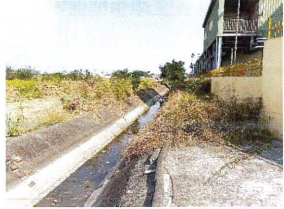
施工與周邊環境情形 114.11.18
