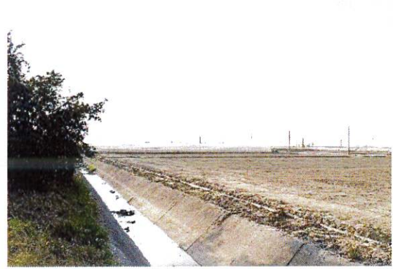
施工周邊環境 114.01.21
