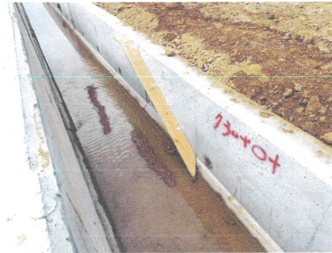
動物逃脫設施(0+730)設置情形 115.02.05
