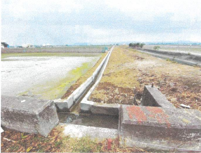
施工終點完工後復原環境 115.02.05
