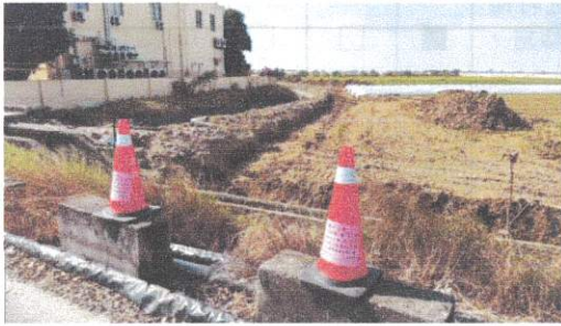
施工位置設置三角錐 114.11.17
