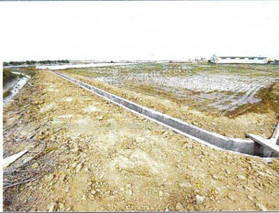
施工復原情形 114.02.04
