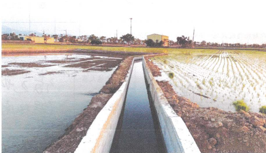
完工後復原環境現況 115.02.05
