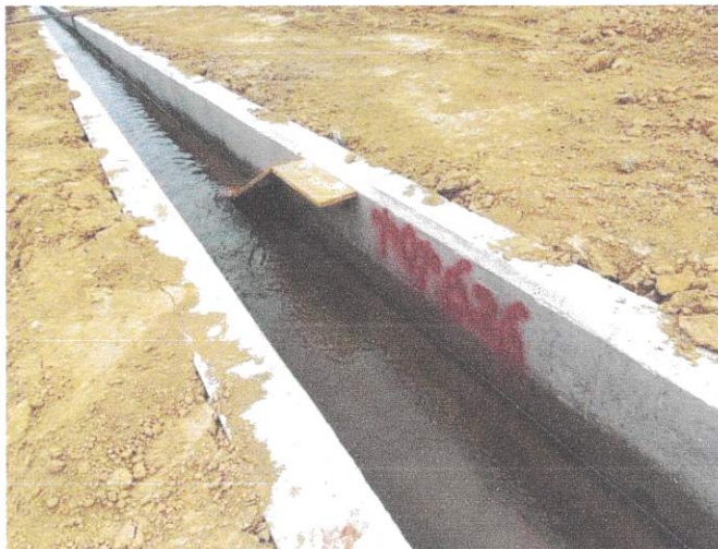
動物逃脫設施(0+626)設置情形 115.02.05
