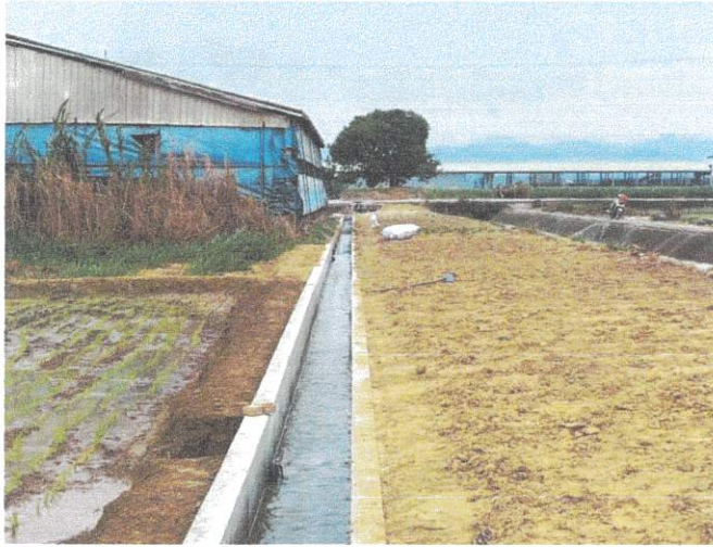
施工起點完工後復原環境 115.02.05
