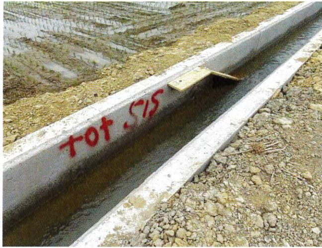
動物逃脫設施(0+515)設置情形 115.02.05
