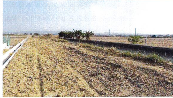
施工便道復原情形 114.01.22
