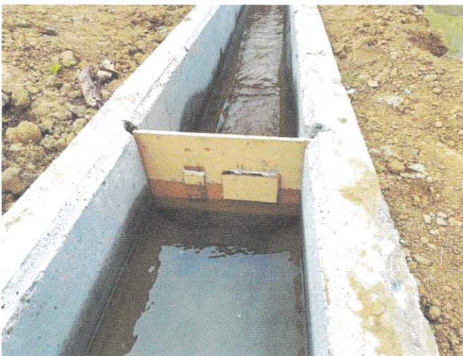
木質擋水板設置 115.02.05
