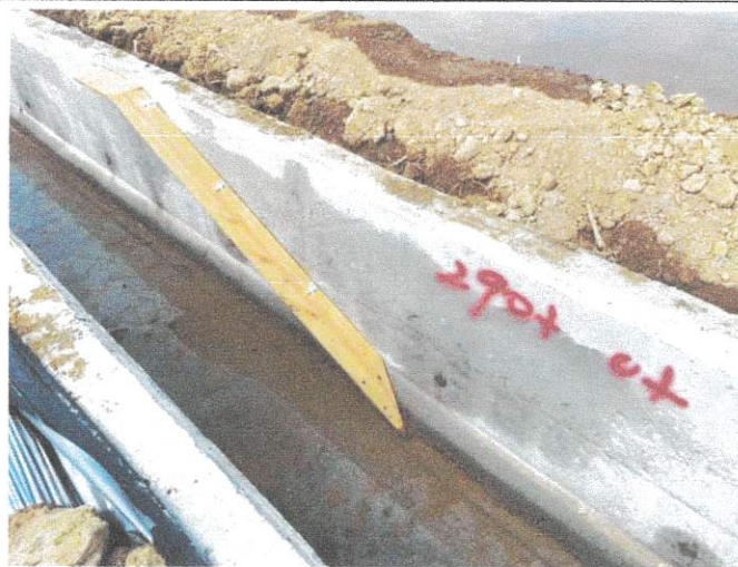
動物逃脫設施(0+290)設置情形 115.02.05
