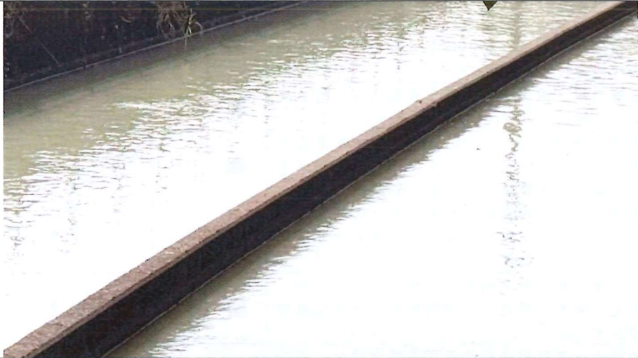
工區旁排水現況115.1.21
