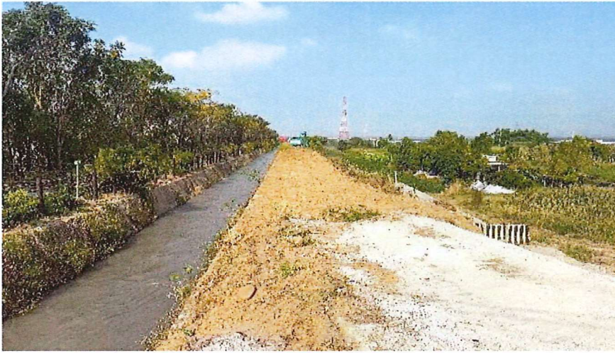
現地施工作業情形 114.11.17
