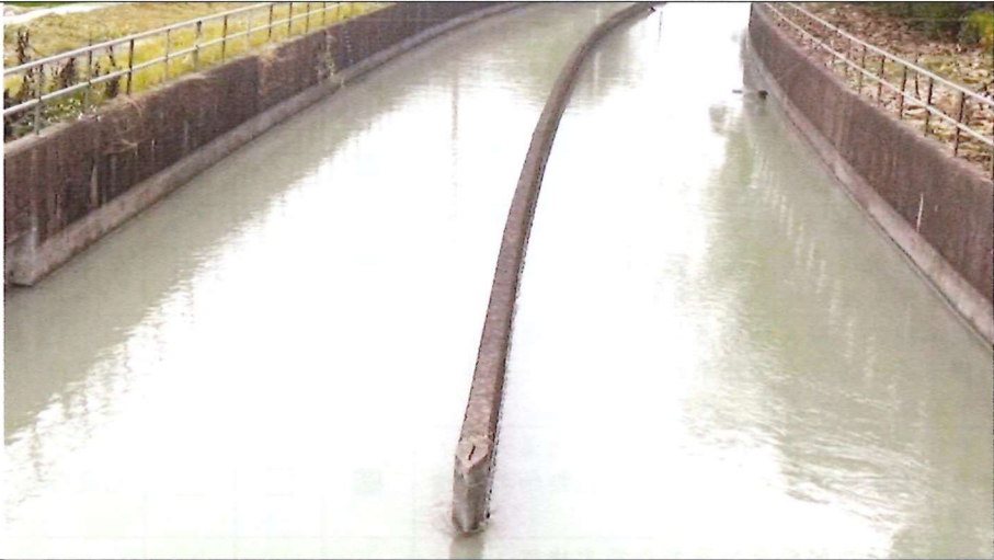
工區旁排水現況 115.3.6
