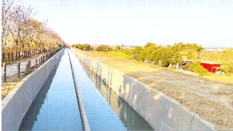
施工作業情形 115.2.4
