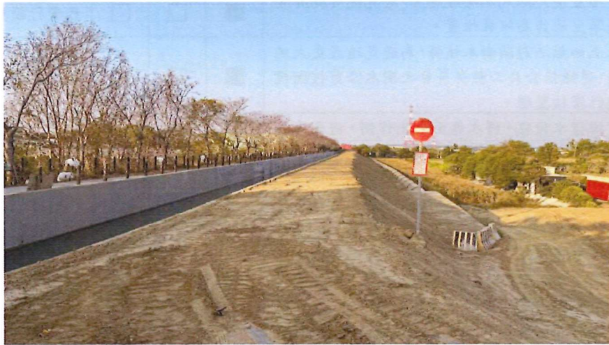
施工現地復原整理 115.2.5
