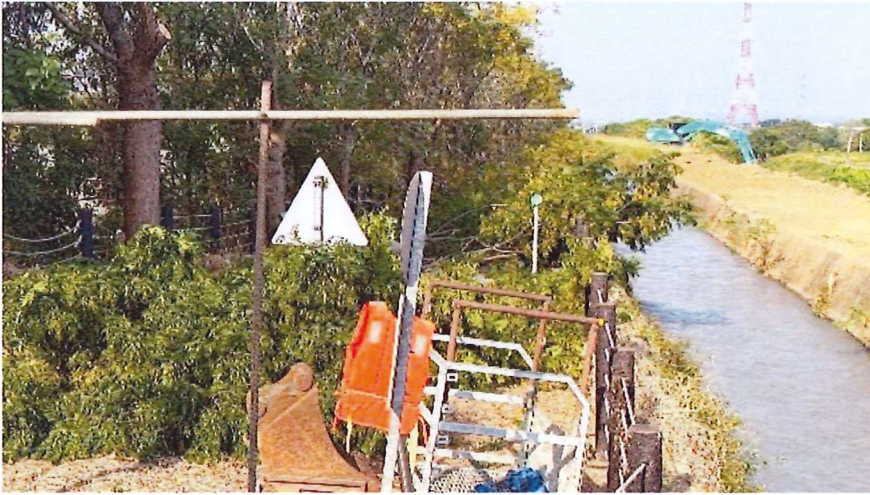
施工動線可能影響範圍進行適當修枝 114.11.17
