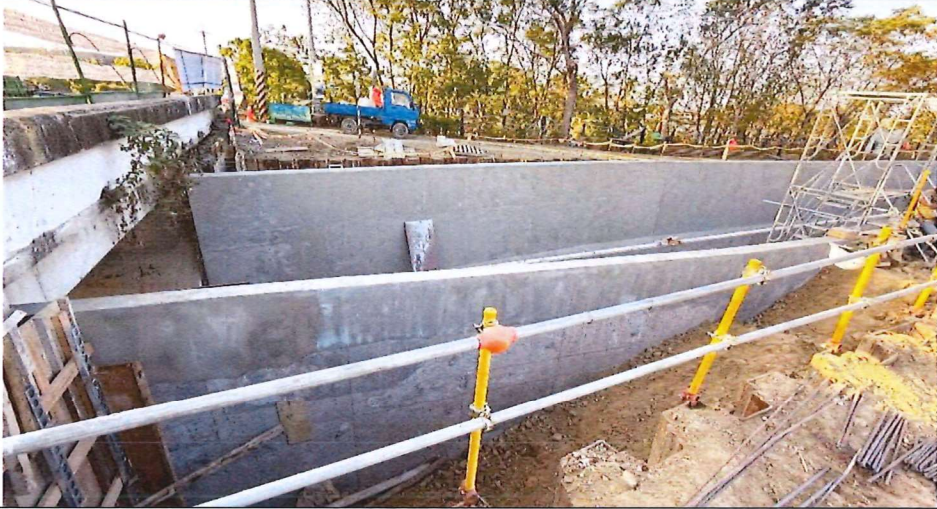
施工作業情形114.12.26
