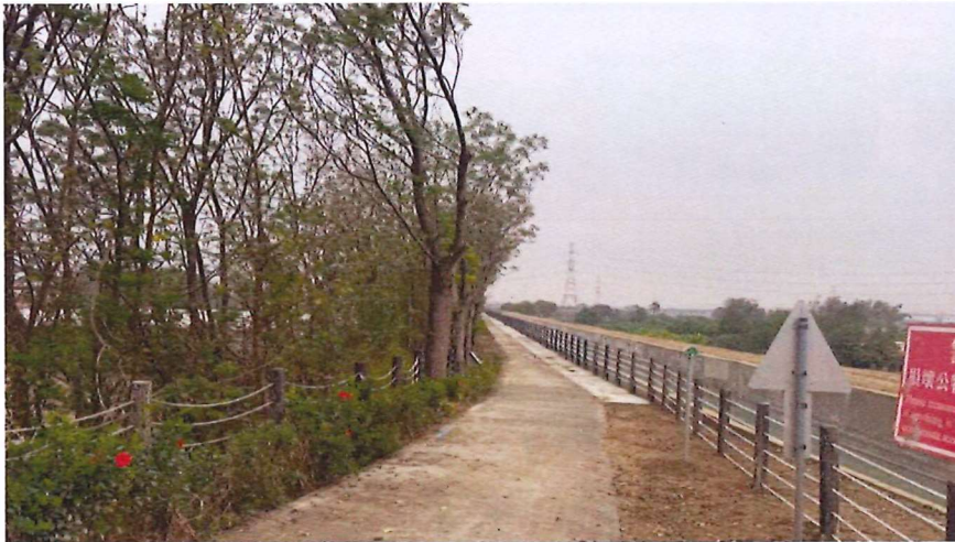
施工現地步道復原現況 115.3.5
