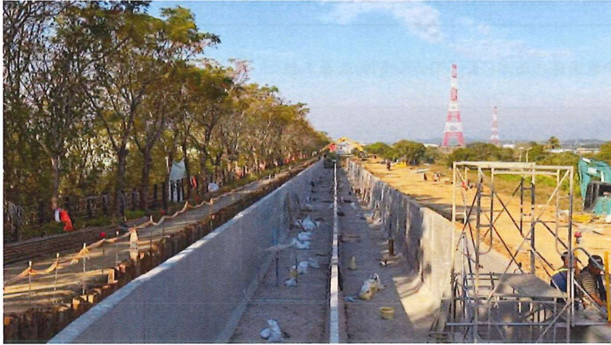
現地施工作業情形 114.12.29
