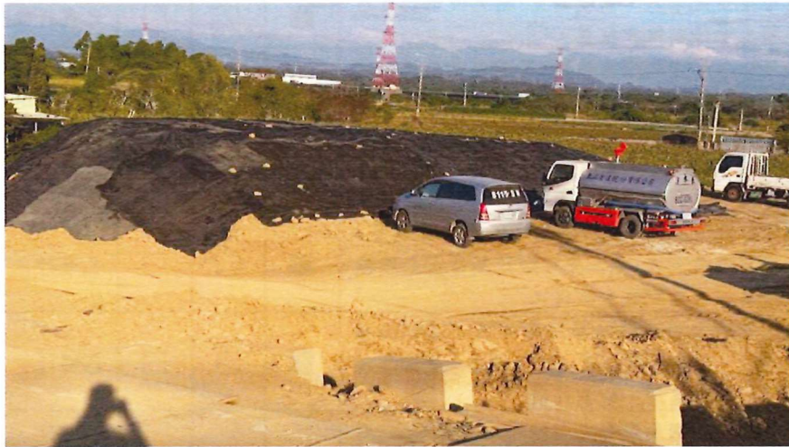
土堆上設置防塵網 114.12.29
