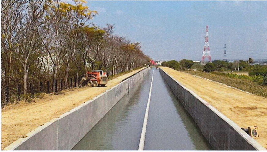
現地施工作業情形 115.1.19
