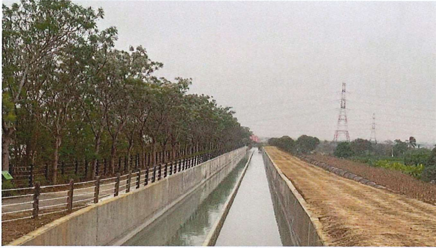
施工現地環境復原現況 115.3.5
