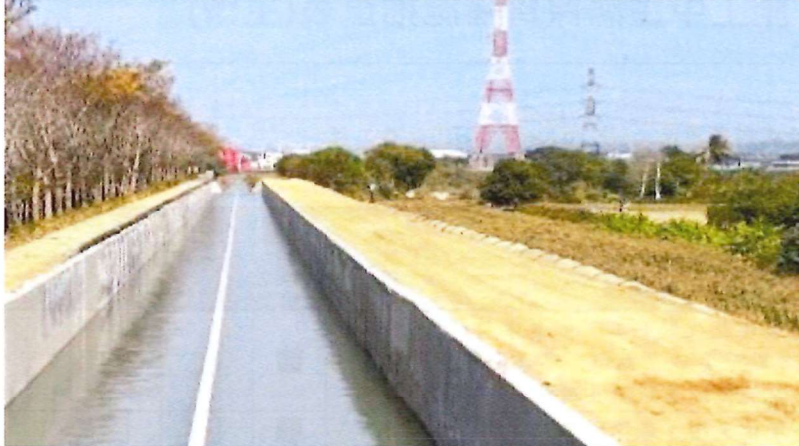
施工作業情形115.1.20
