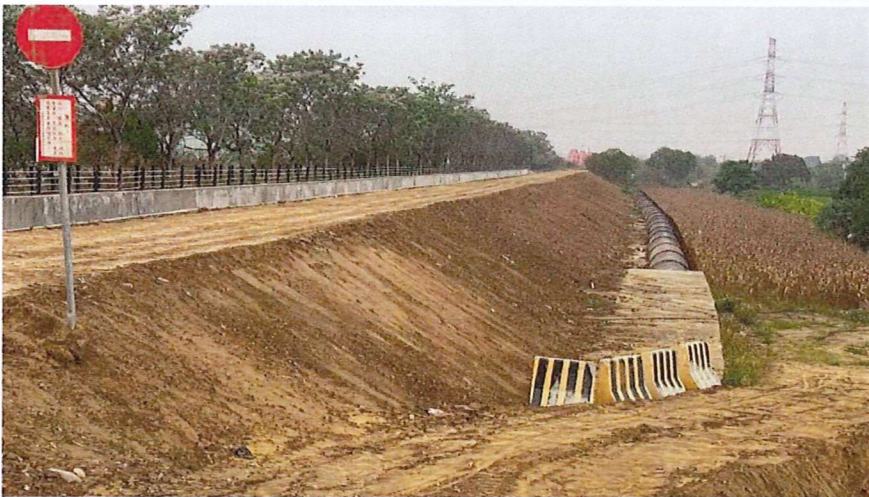
施工現地邊坡復原現況 115.3.5
