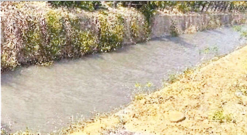
工區旁排水現況114.11.19
