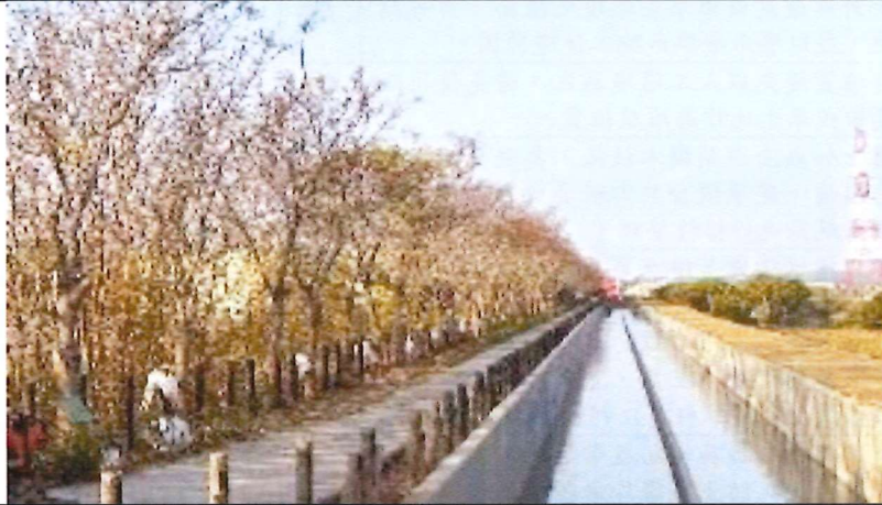
施工步道復原整理 115.2.4
