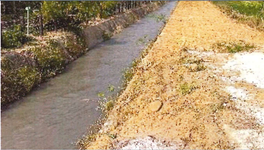
施工作業情形114.11.19
