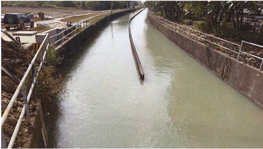
工區旁排水水體情形 115.1.19
