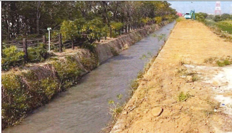
工區旁排水水體情形114.11.18
