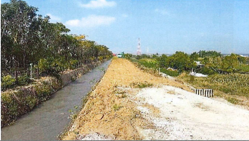
現地施工作業情形114.11.17
