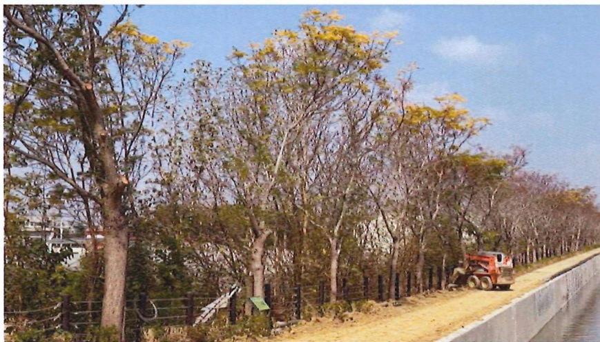
施工動線可能影響範圍進行適當修枝 115.1.19
