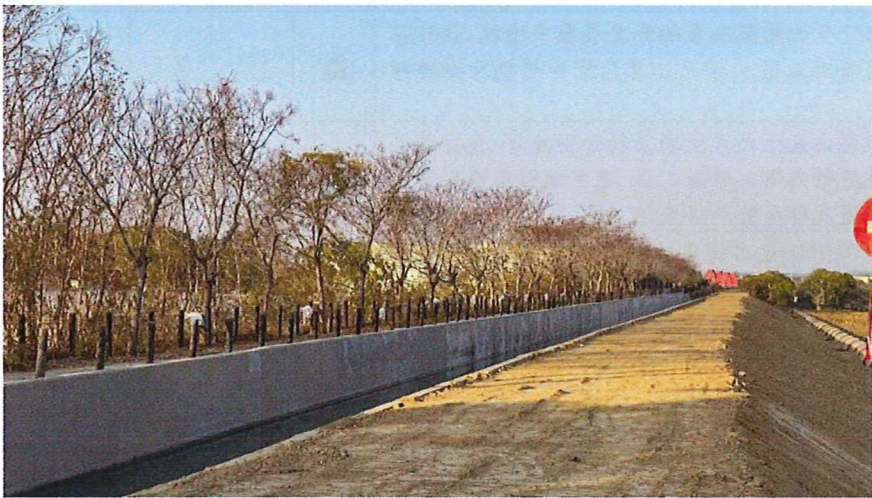
施工現地步道圍籬復原 115.2.5
