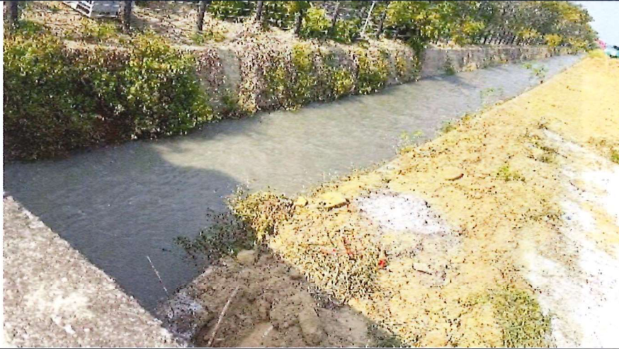
工區旁排水水體情形114.11.17
