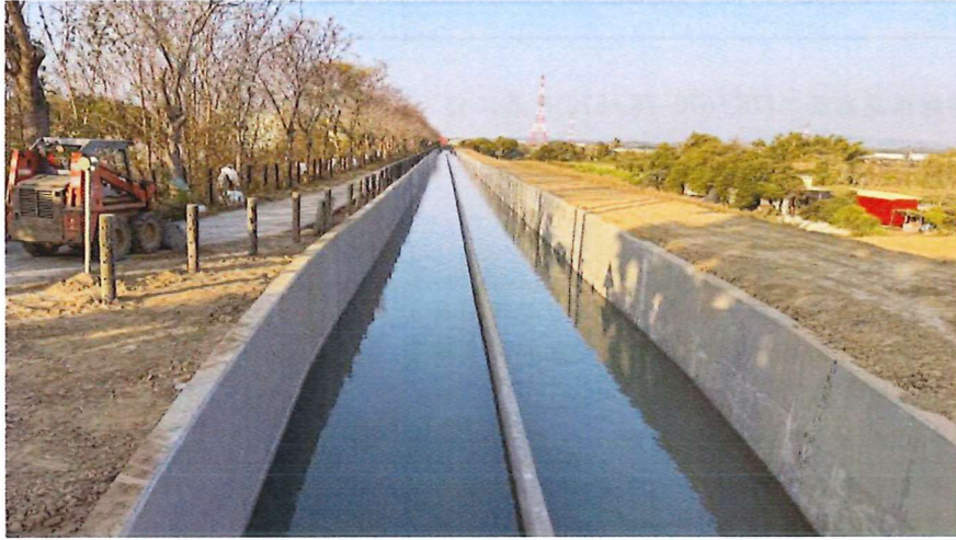
現地施工作業情形 115.2.5
