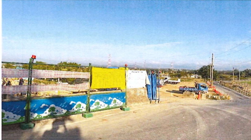
施工作業情形，優先利用既有道路通行 114.12.30
