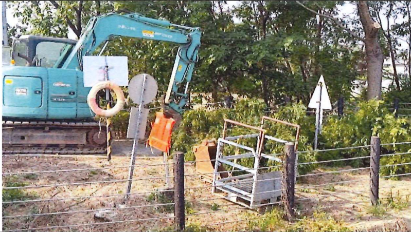
施工動線可能影響範圍進行適當修枝114.11.18
