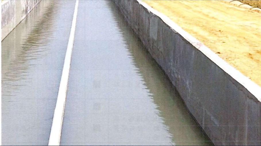
施工作業情形115.1.21
