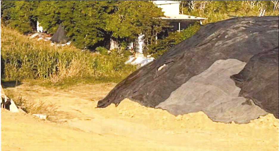
土方鋪設防塵網114.12.26
