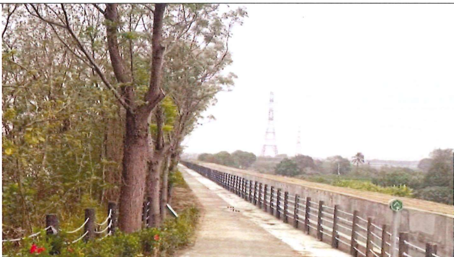
施工地步道現況 115.3.6
