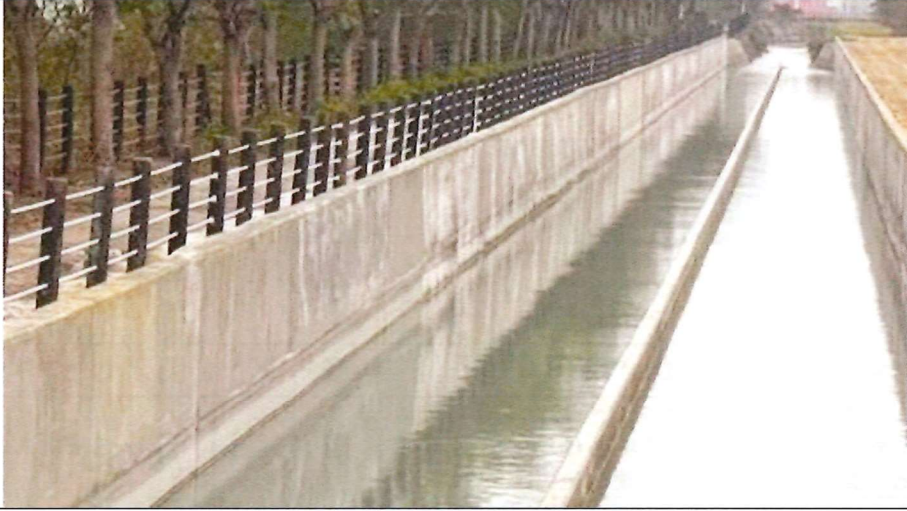
施工作業情形 115.3.6
