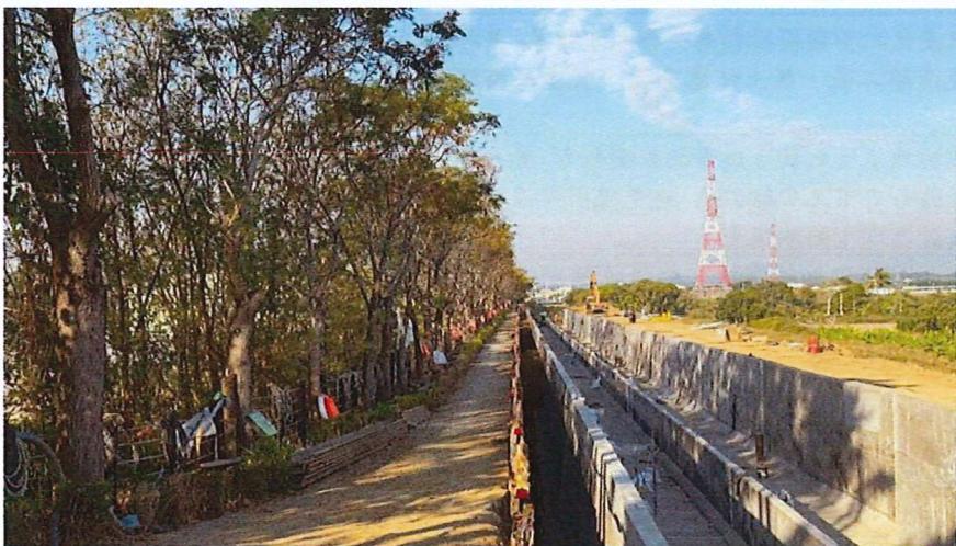
施工動線可能影響範圍進行適當修枝 114.12.29
