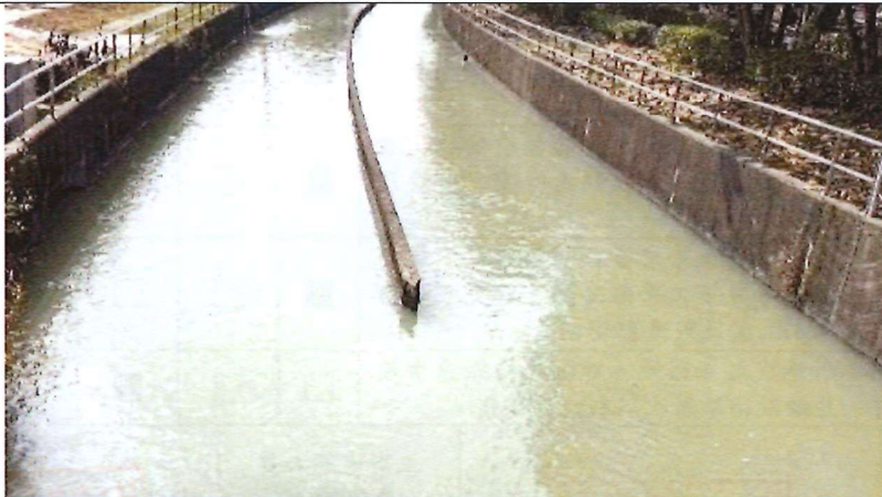
工區旁排水水體情形 115.1.20
