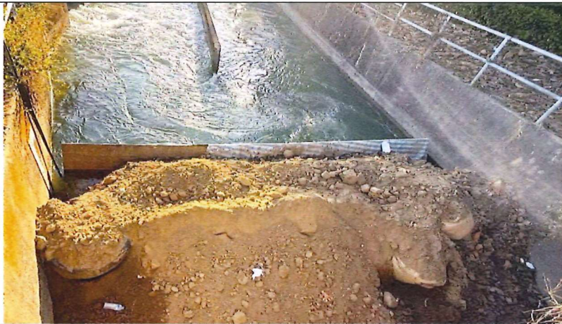
工區旁排水設置臨時擋水措施 114.12.30
