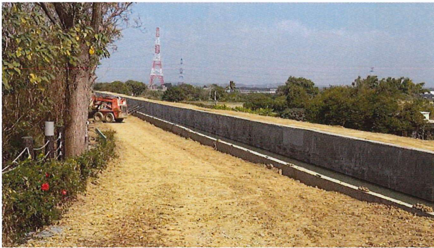
施工現地復原整理 115.1.19
