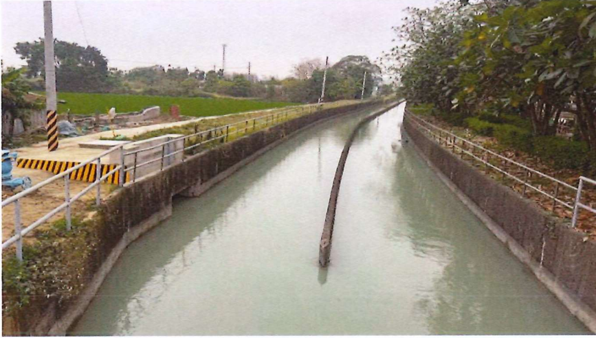
工區旁排水水體情形 115.3.5
