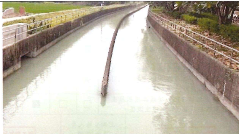
工區旁排水水體情形 115.3.4
