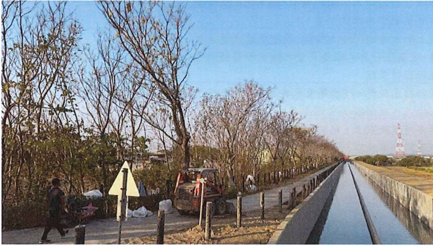
施工現地步道復原整理 115.2.5
