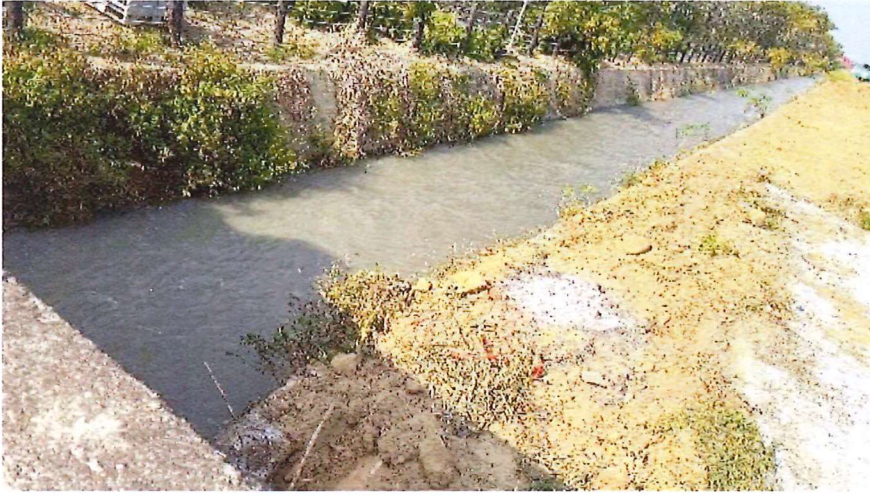
工區旁排水水體情形 114.11.17
