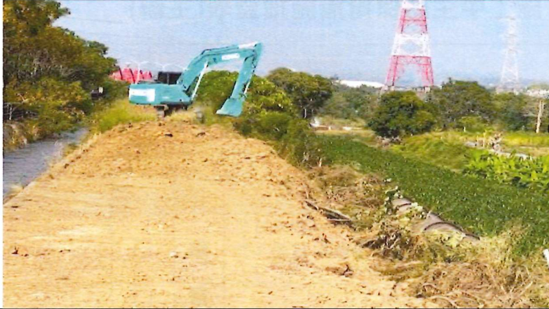
施工作業情形114.11.18
