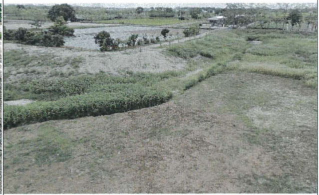
說明：林初埤C工區景觀植栽工程照
