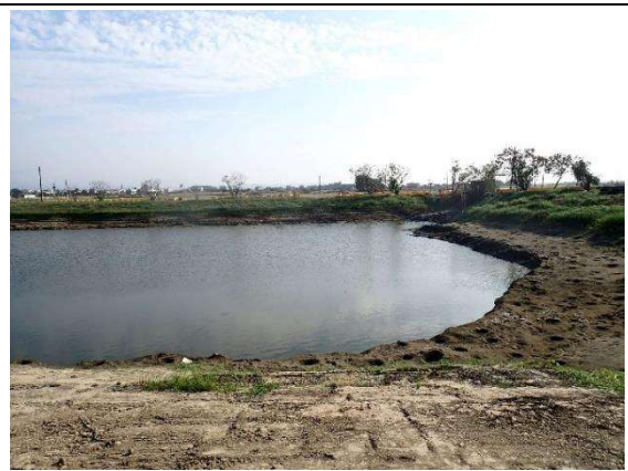
本次調查現況-施工區域
