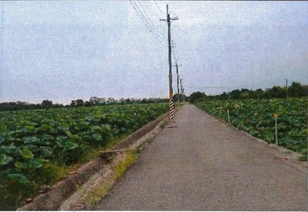
說明：林初埤新增500mm管路處環境照
