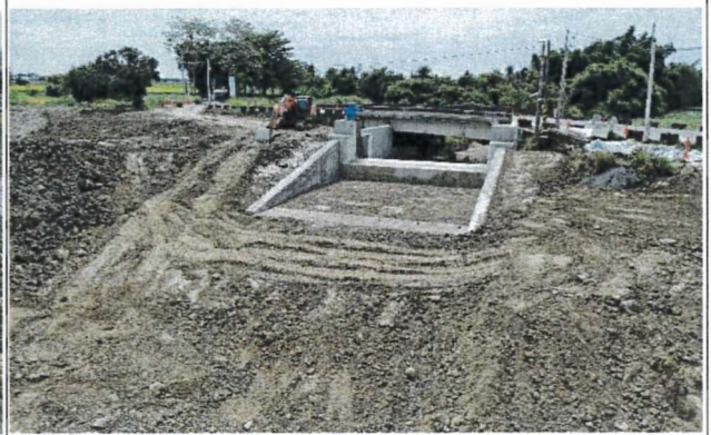
說明：林初埤A工區排洪道工程照
