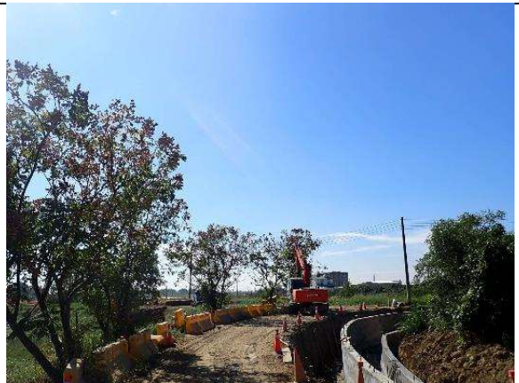
林初埤周邊環境-施工現況
