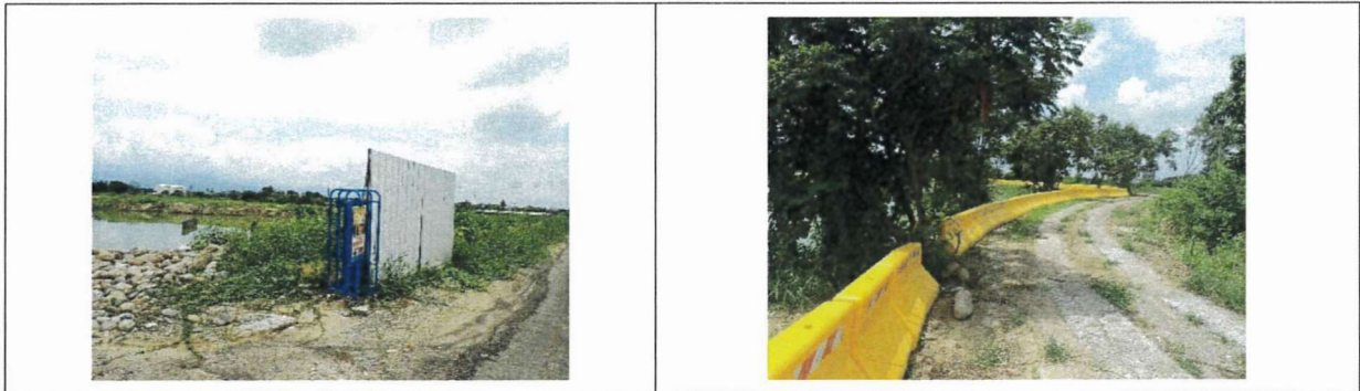
本次調查現況-施工區域
