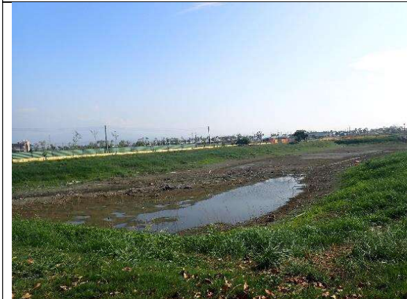
林初埤周邊環境-計畫區內水域遭抽空
