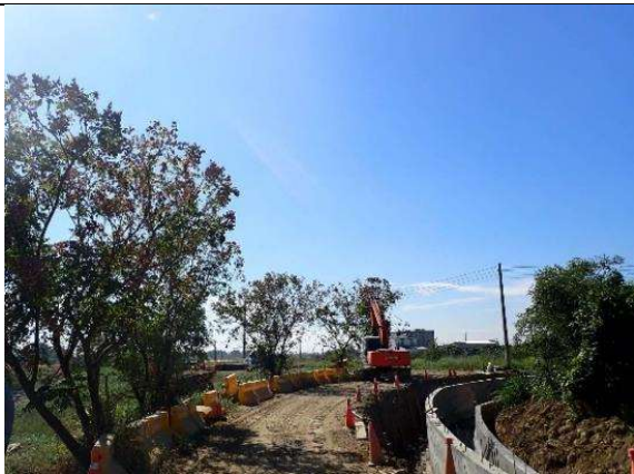
本次調查現況-施工區域
