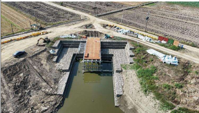
說明：林初埤B工區箱型石籠工程照
