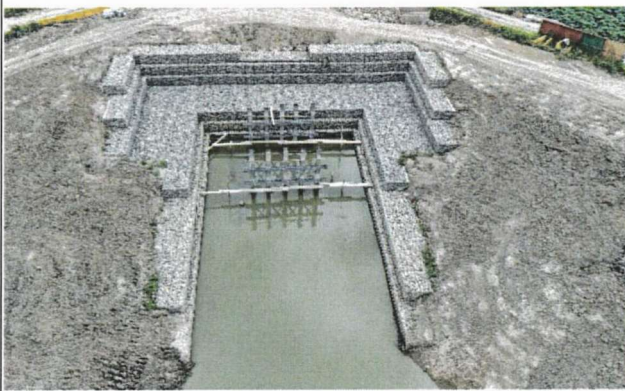
說明：林初埤B工區箱型石籠工程照
