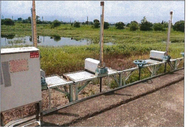
說明：林初埤既有水門
