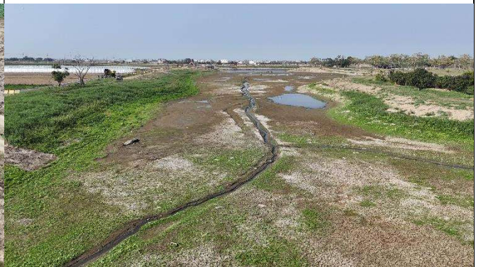
說明：林初埤C工區景觀植栽工程照
