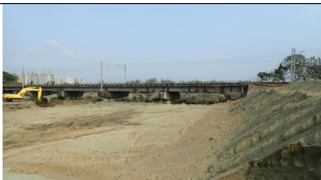
環境照-施工中溪床
