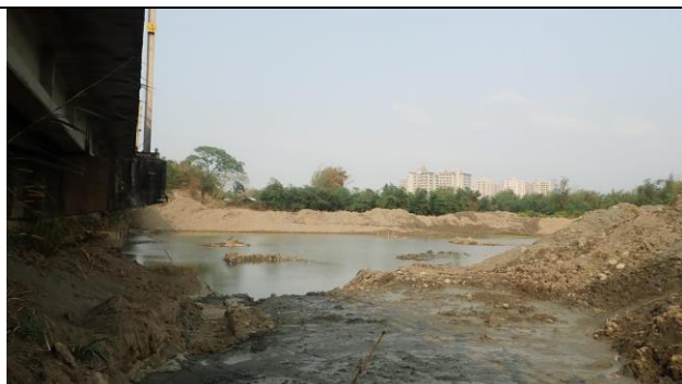
環境照-鐵路橋下施工中溪床
