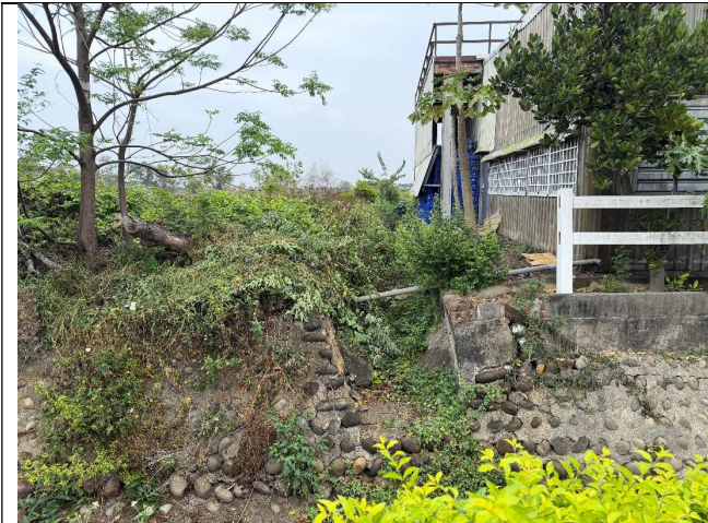
時間：115年2月28日 說明：營南小給一工區現況
