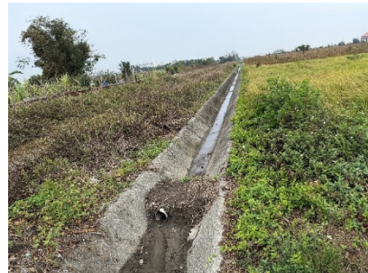
後港小排二之五周邊棲地環境現況
