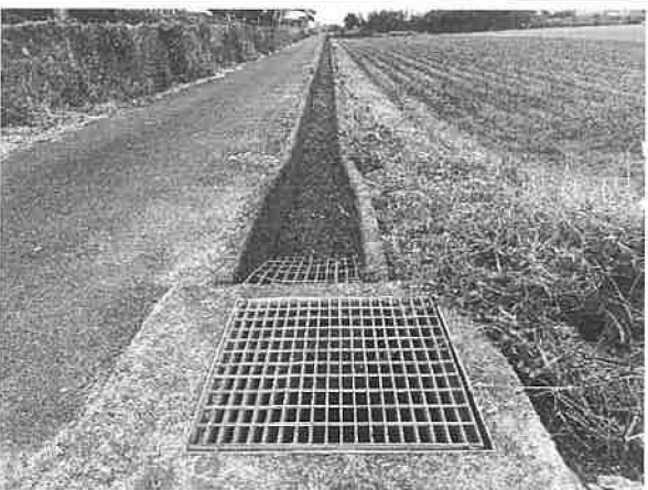
時間：114.09.19 說明：蘇厝小給 3 起點上游銜接既有渠道。
