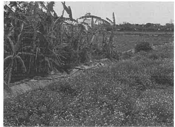
時間：114.09.19 說明：東茄拔小給 2-1 現況。
