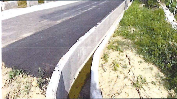
工程施作處現況 115.5.4
