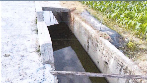
工程施作處現況 115.1.6
