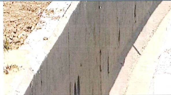
工程施作處現況 115.4.15
