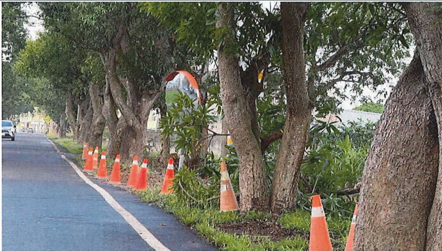
以三角錐區隔行道樹範圍，避免工程擾動影響(115.03.06)
