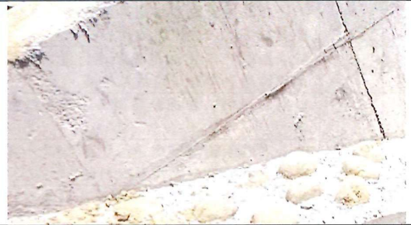
設置生態爬坡 115.4.16
