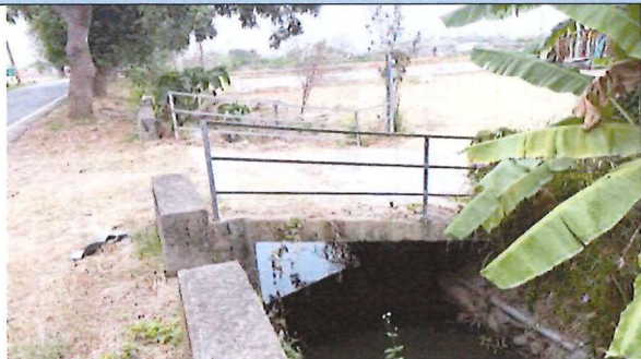
工程施作處現況 115.2.5
