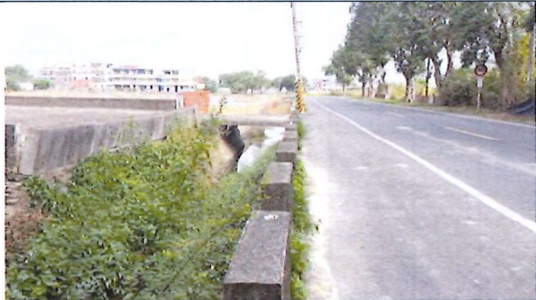
工程施作處現況 115.1.6
