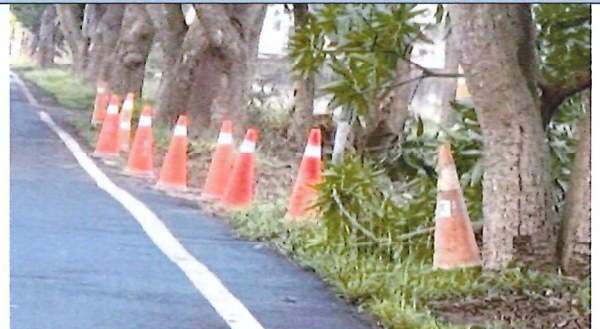
利用三角錐限制施工擾動區 115.3.4
