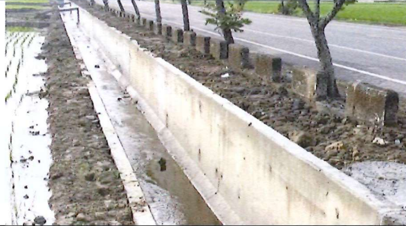
工程施作處現況 115.3.5
