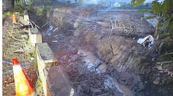
工程施作處現況 115.3.5
