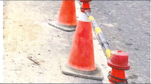
利用三角錐區隔工區擾動範圍 115.2.9
