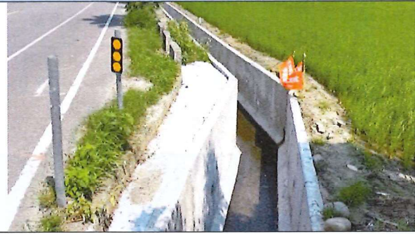
工程施作處現況 115.4.15
