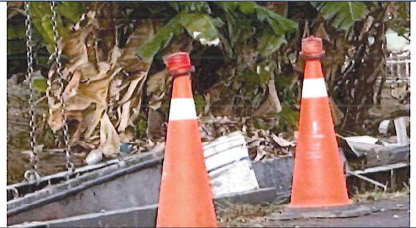
利用三角錐限制施工擾動區 115.3.4
