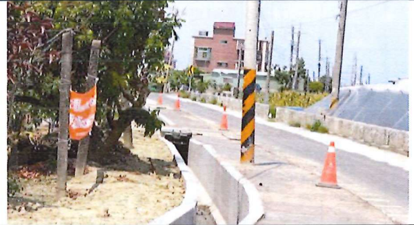
利用三角錐限制施工擾動區 115.4.16
