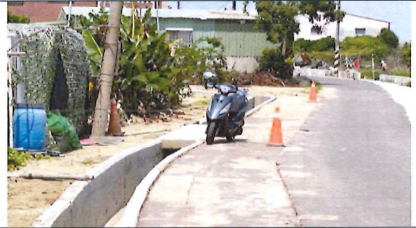
使用三角錐限制施工擾動區 115.4.15
