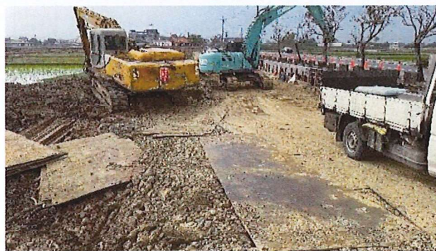
以裸露地作為施工便道(115.02.06)
