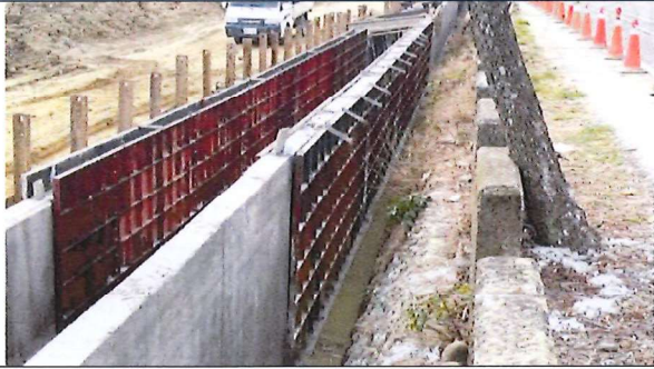
工程施作處現況 115.2.5
