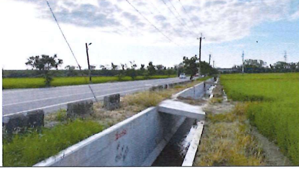
工程施作處現況 115.5.4
