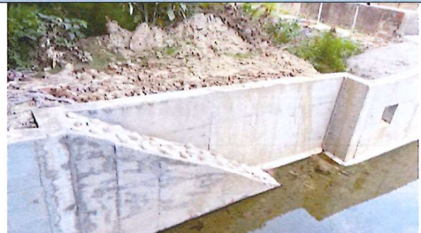
設置生態爬坡 115.5.5
