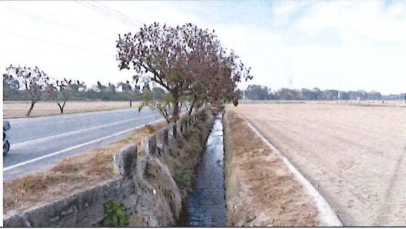
工程施作處現況 115.1.6
