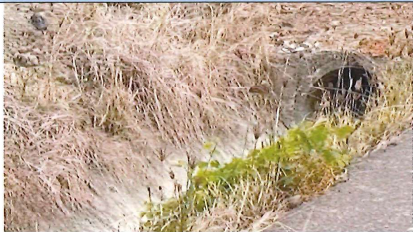
工程施作處現況 115.2.5
