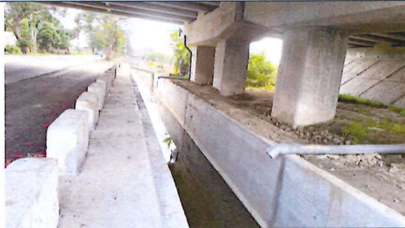
工程施作處現況 115.5.4
