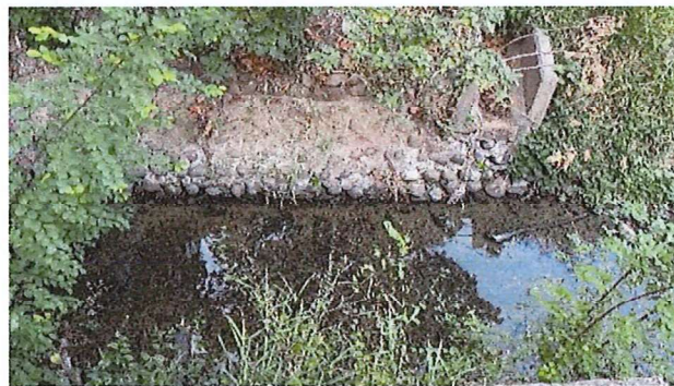
渠道水體現況(115.01.07)
