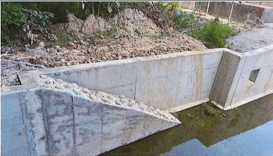
設置生態生善廊道(115.05.06)
