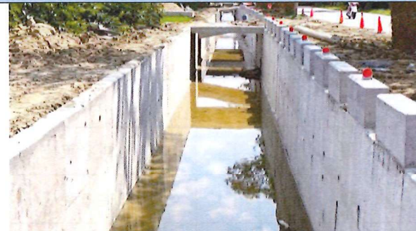
工程施作處現況 115.4.15
