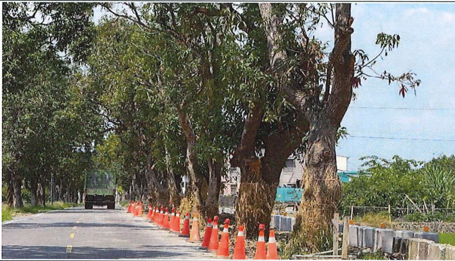
以三角錐區隔行道樹範圍，避免工程擾動影響(115.04.13)
