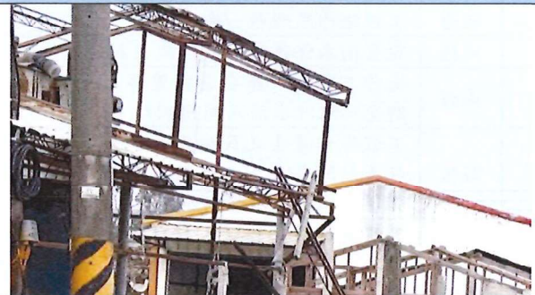
工區周邊建物 115.2.9
