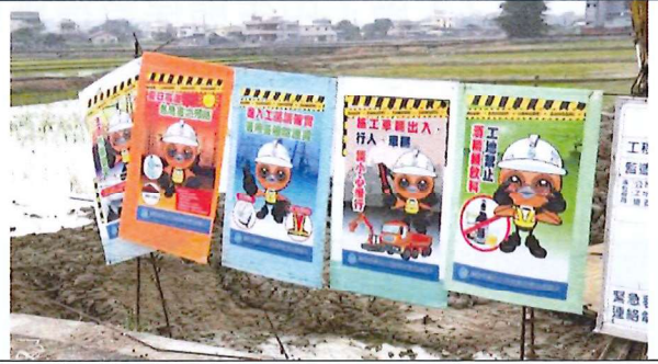
施工期間設置工程告示牌 115.2.5
