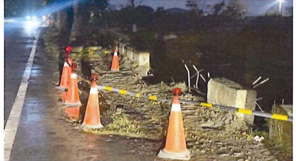
使用三角錐限制施工擾動區 115.3.5
