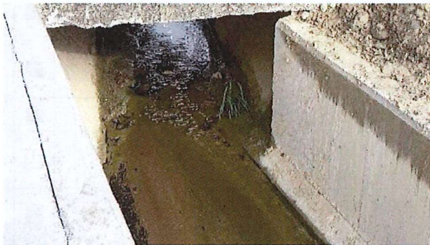
渠道水體現況(115.03.06)
