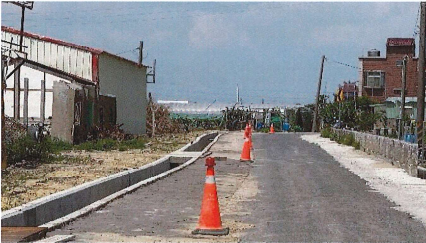
限制施工環境擾動範圍 (115.04.13)
