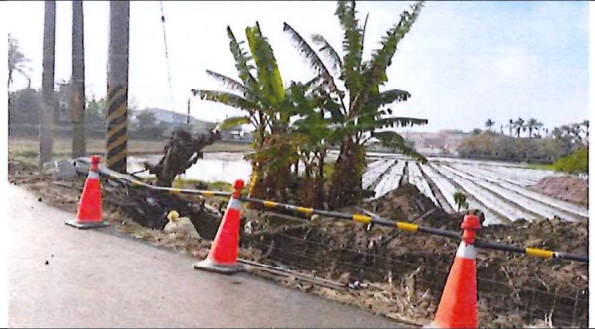
使用三角錐限制施工擾動區 115.3.5
