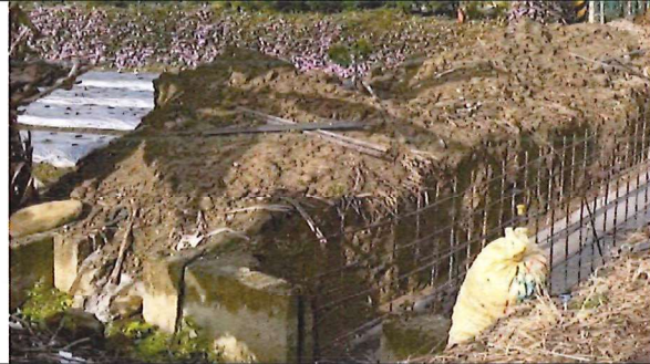
工程施作處現況 115.3.5
