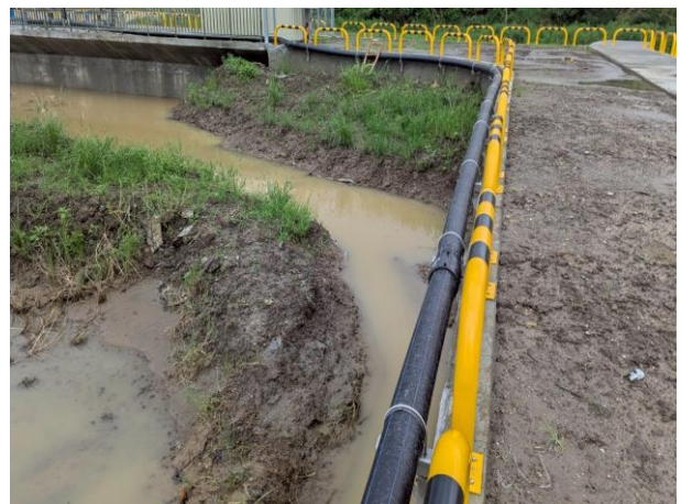
時間：114年7月30日 說明：頂埤抽水站導水路
