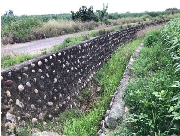
說明：東後寮小排 2-4 現勘
