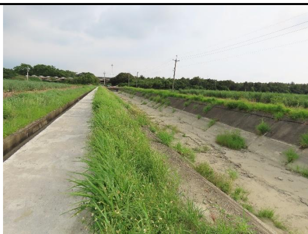
工區二環境照
