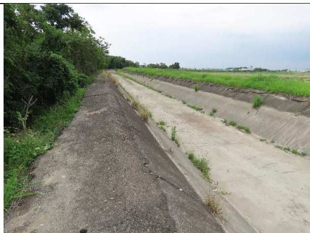
工區二環境照
