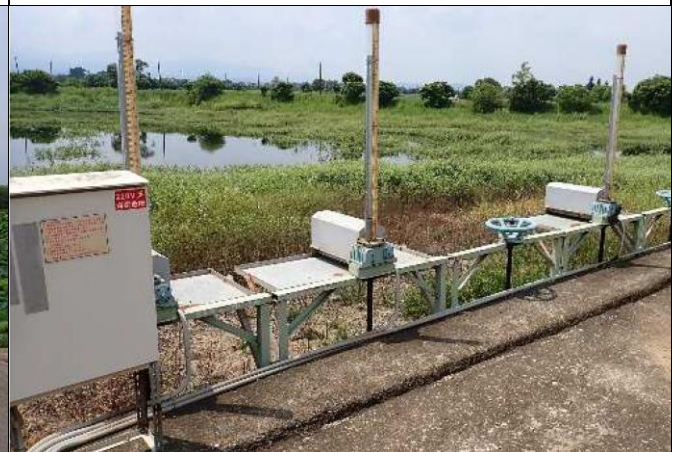
說明：林初埤既有水門
