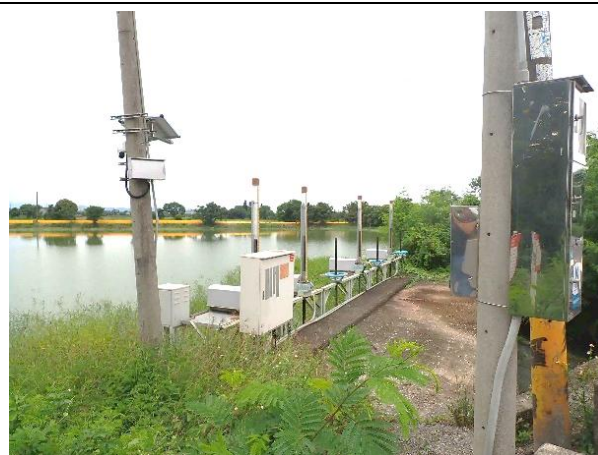
說明：林初埤既有水門(113/07)
