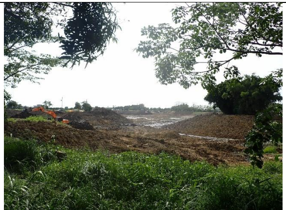
林初埤周邊環境-施工現況
