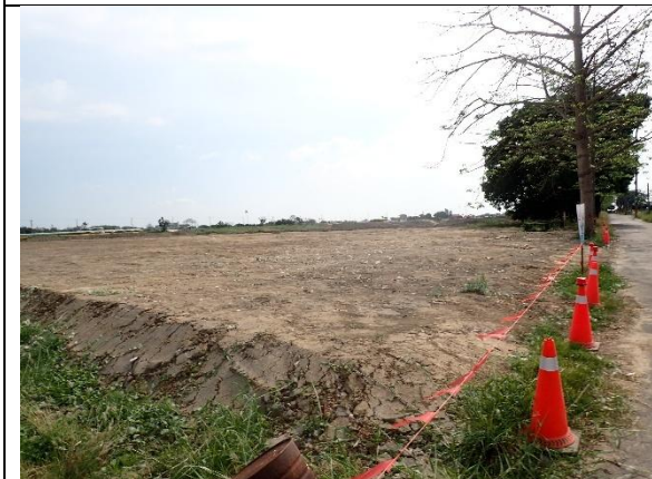
林初埤周邊環境-土方暫置處
