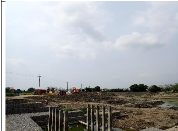
林初埤周邊環境-施工現況
