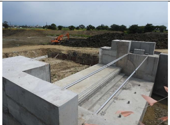
林初埤周邊環境-新增設水門
