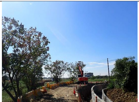
林初埤周邊環境-施工現況
