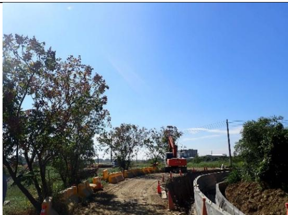
本次調查現況-施工區域
