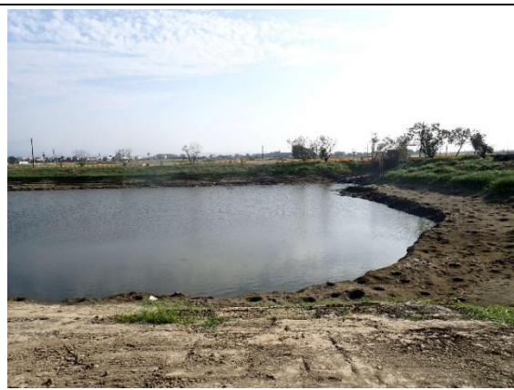
本次調查現況-施工區域
