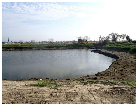
本次調查現況-施工區域
