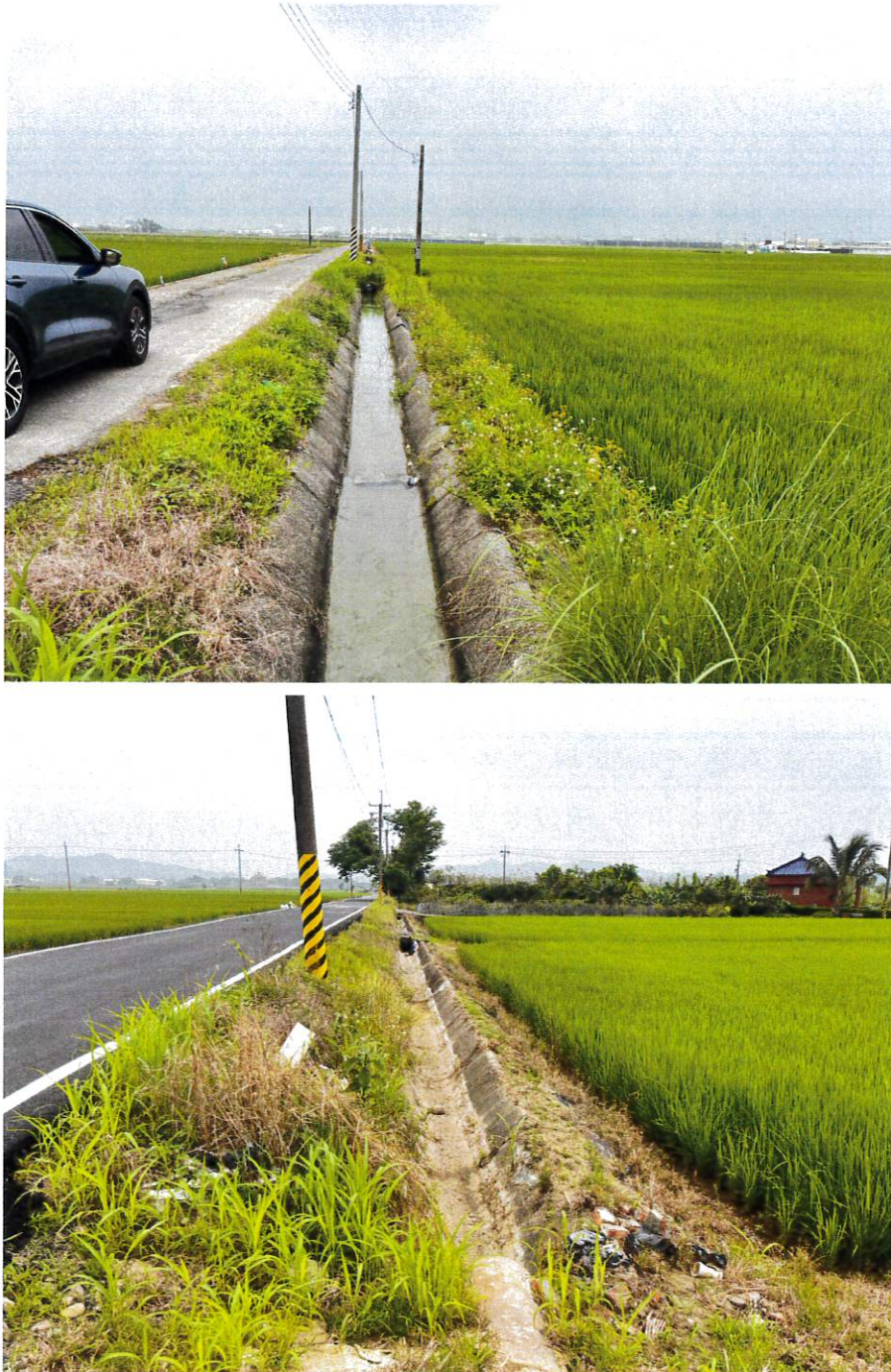
圖 1.查畝營小給 1-3 等 2 線調度設施強化工程現場環境照
