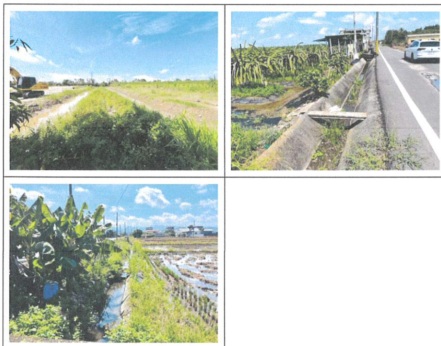
圖 1.3 線預計執行生態檢核之溝渠現況。
