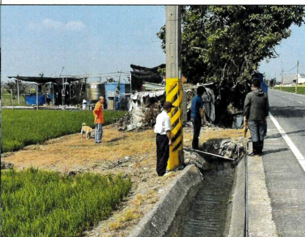
說明：寮子小給 3-3 現勘
