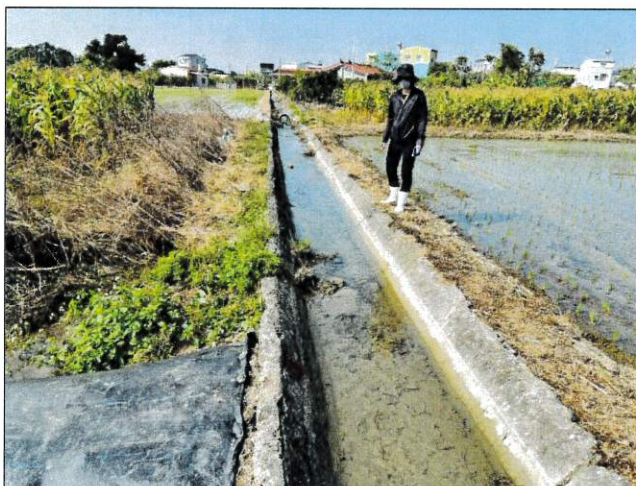
說明：南安溪寮小給 2-13 現勘
