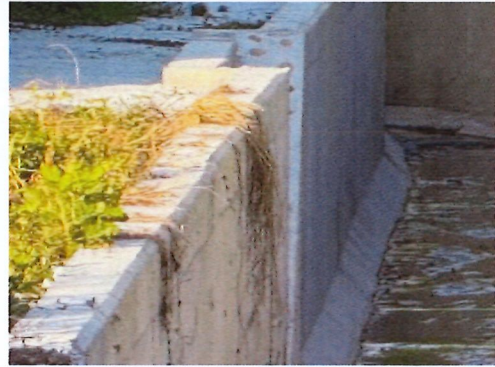
設置生態逃生通道(115.06.23)
