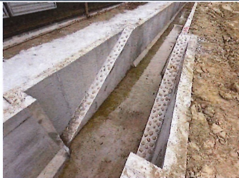
設置生態逃生通道(115.02.06)
