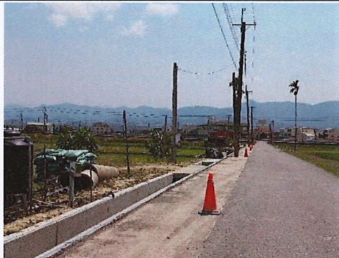
以三角錐限縮擾動範圍(115.04.14) 工區二-馬稠後二輪小給二之二十三
