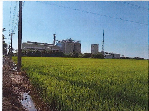
工區周邊農耕地(115.05.06)
