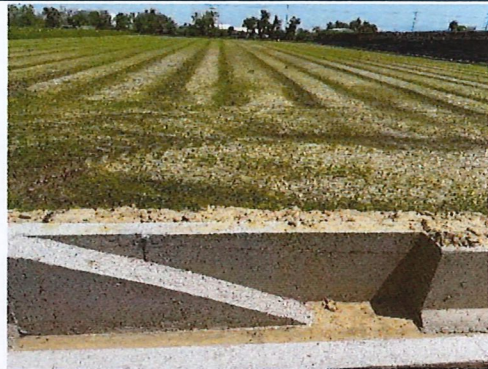
設置生態逃生通道(115.04.14)
