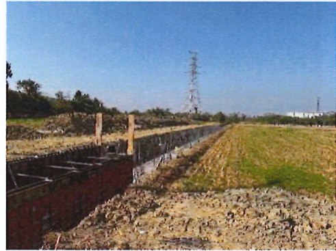
工區周邊農耕地(115.01.19)
