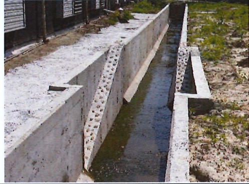
設置生態逃生通道(115.04.14)
