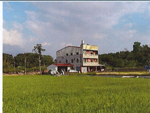
工區周邊農耕地(115.05.06)
