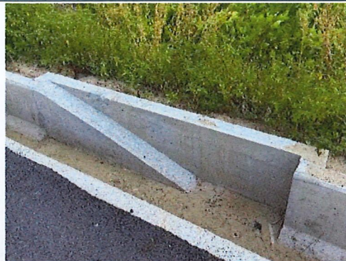
設置生態逃生通道(115.06.23)
