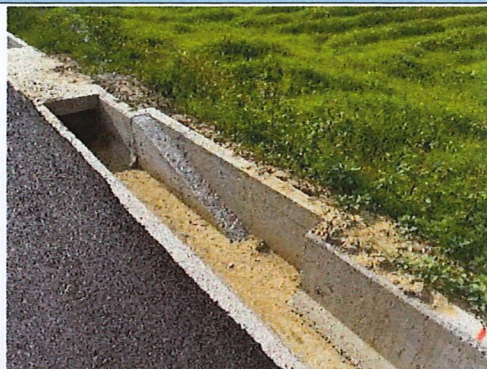
設置生態逃生通道(115.05.06)
