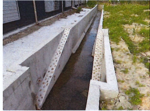
設置生態逃生通道(115.05.06)
