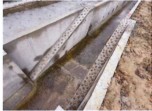
設置生態逃生通道(115.03.05)
